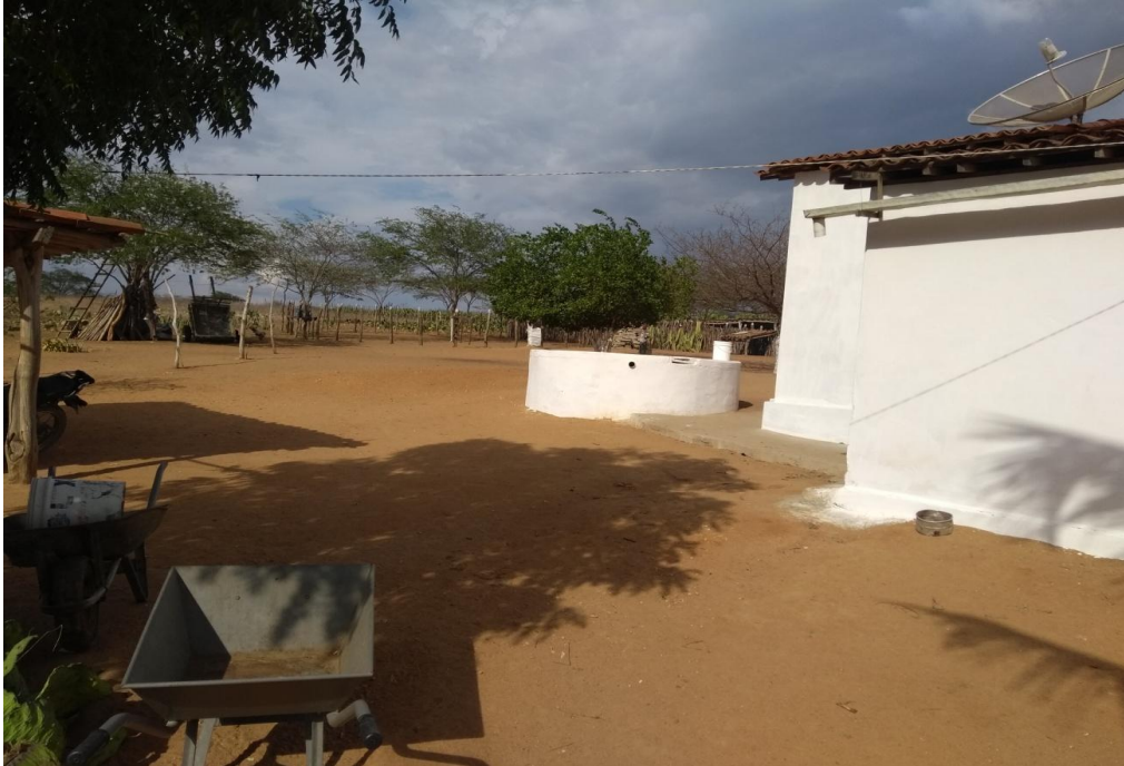
Imagem 1 – Cisterna de captação de águas da chuva, em área rural na cidade de Cubati-PB
