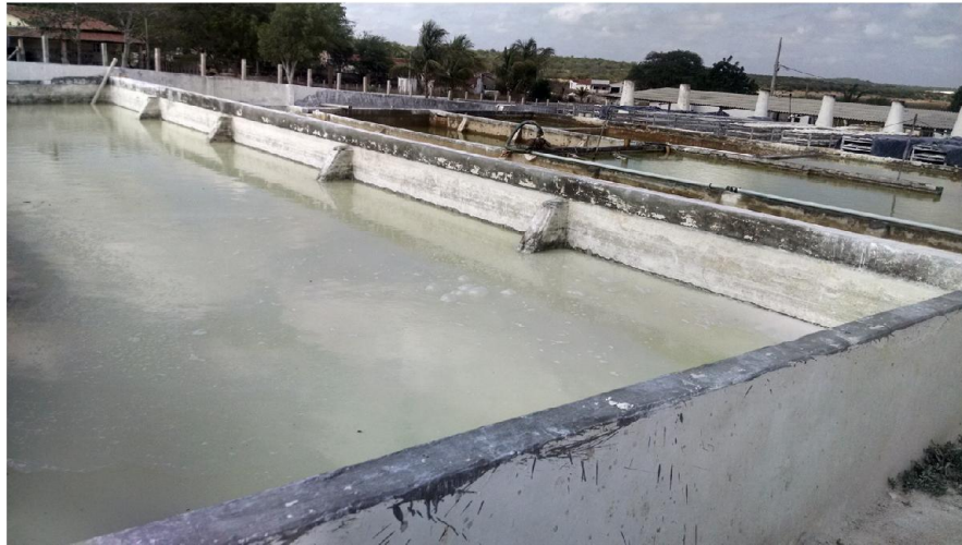
Figura 2.3: Caulim misturado a água em tanques de separação para retirada de impurezas. Mineradora Incomgel em Juazeirinho - PB.
