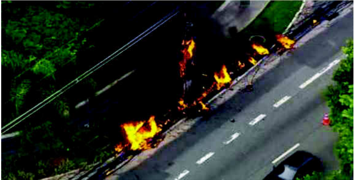
Figura 6 - Registro fotográfico do incidente ocorrido no dia 28/02/2020 na rede de telecomunicações.
