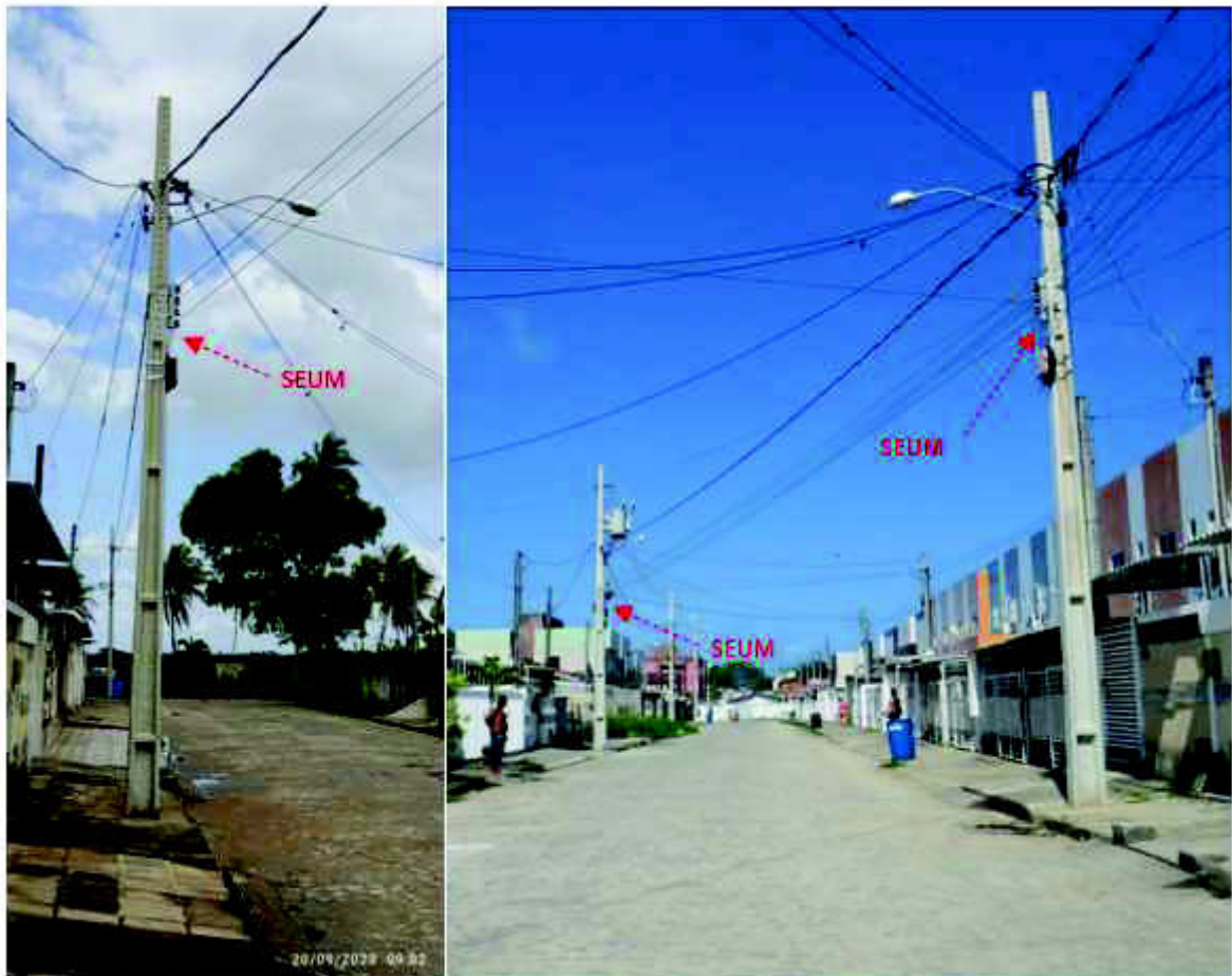
Figura 26 - Aplicação Suporte Extensor Uso Mútuo (SEUM) em campo.
