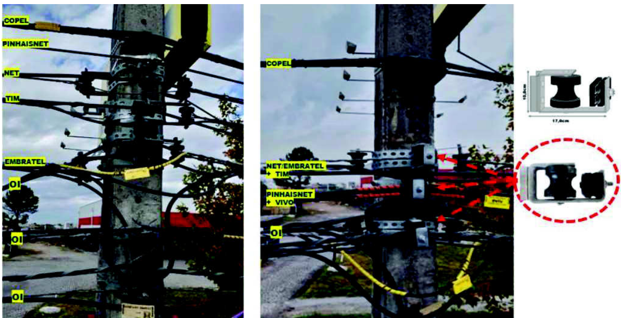
Figura 23 - Suporte Multiplicador de Pontos (imagem à esquerda do antes e imagem à direita do após).
