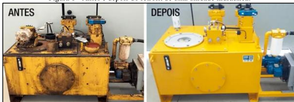
Figura 1 - Antes e depois do retrofit de uma unidade hidráulica.
