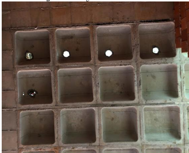
Figura 11: Passagens das bacias sanitárias.
