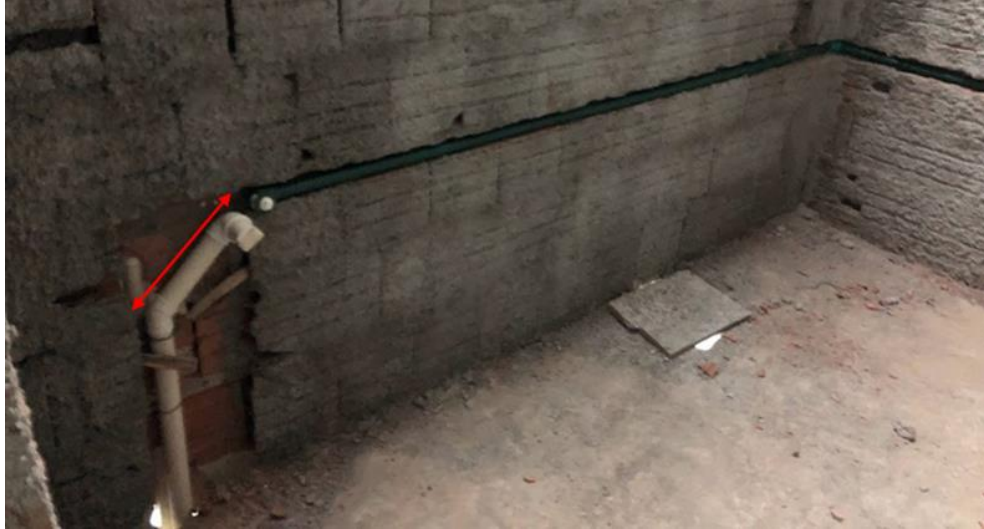
Figura 12: Desvio da tubulação para o lavatório do banheiro para PCD.
