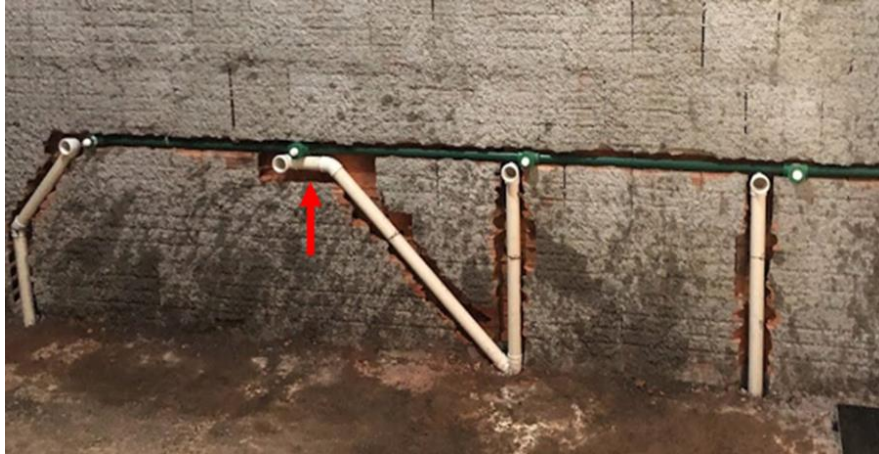
Figura 17: Instalação hidrossanitárias dos lavatórios.
