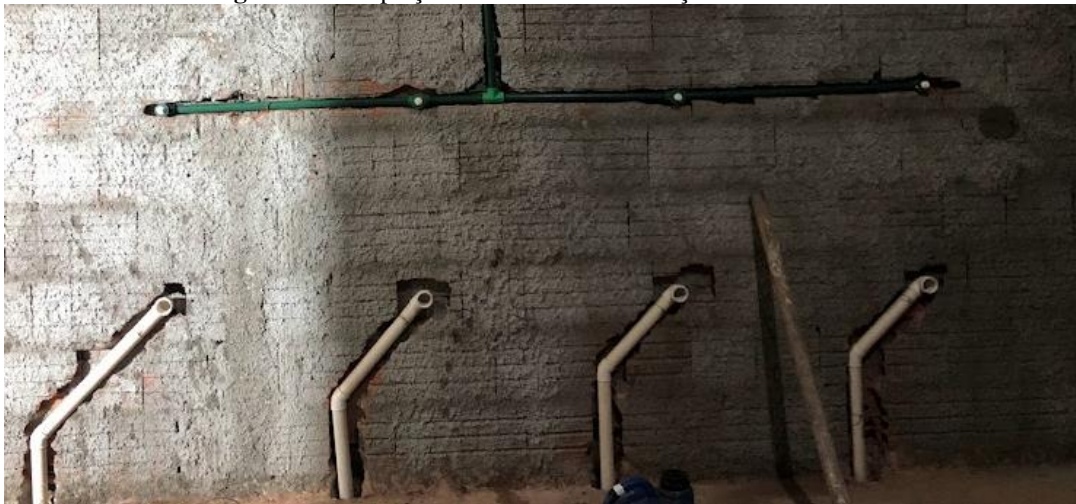
Figura 16: Adaptações realizadas na tubulação dos mictórios.
