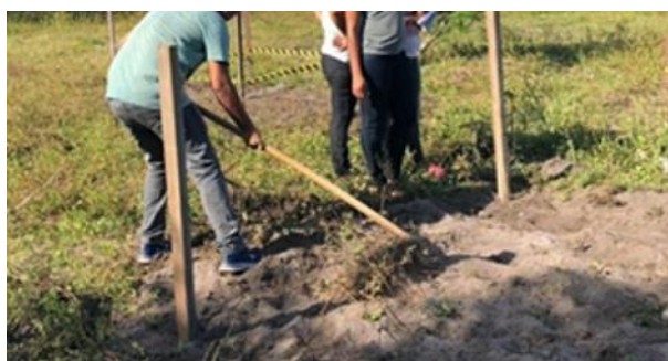
(a) Retirada da cobertura vegetal e cercamento.
