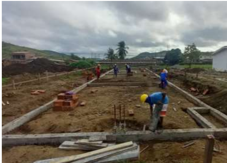
Figura 48 - Finalização da viga baldrame
