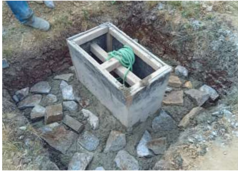
Figura 68 - Processo de concretagem (camada de pedra rachão)
