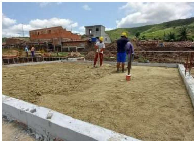
Figura 49 - Aterro e apiloamento de caixão
