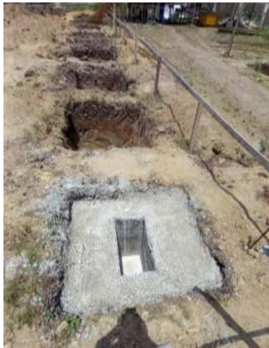
Figura 71 - Resultado final da sapata em concreto ciclópico
