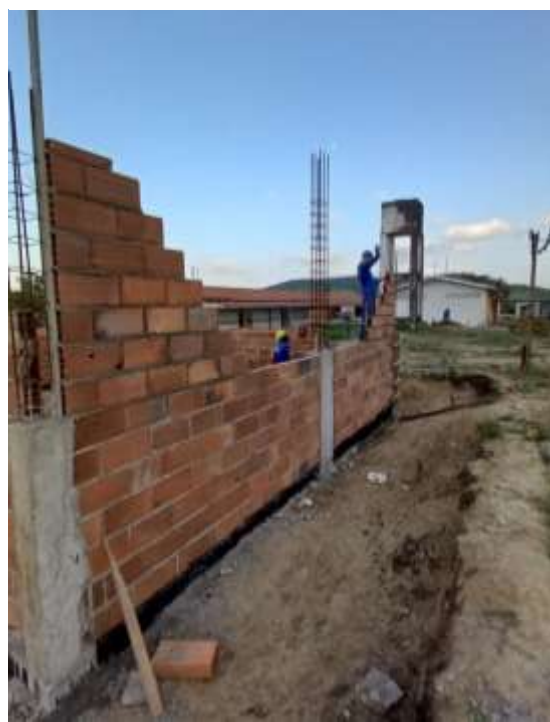
Figura 53 - Alvenaria de elevação
