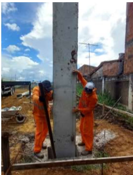
Figura 72 - Instalação de pilar pré-moldado (prumo)
