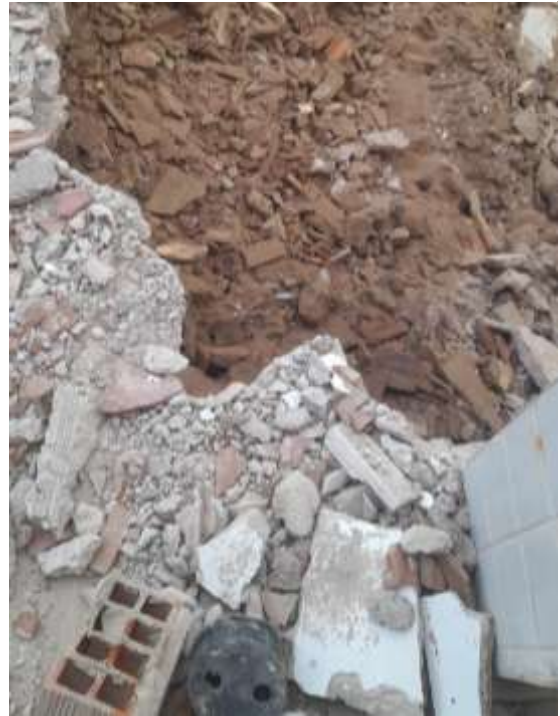
Figura 12 - Vista do aterro da secretaria demolida 2
