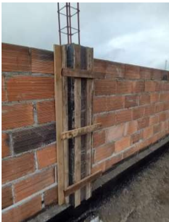
Figura 52 - Abafamento com fôrma de madeira nos pilares
