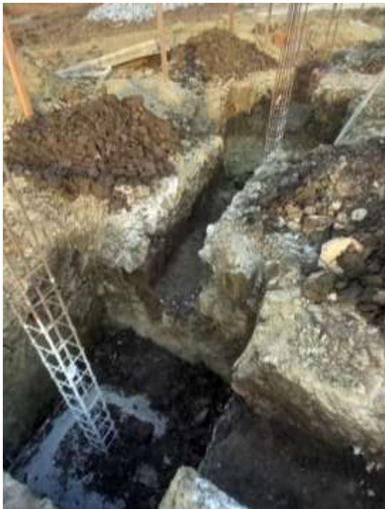
Figura 41 - Reaterro das valas das sapatas
