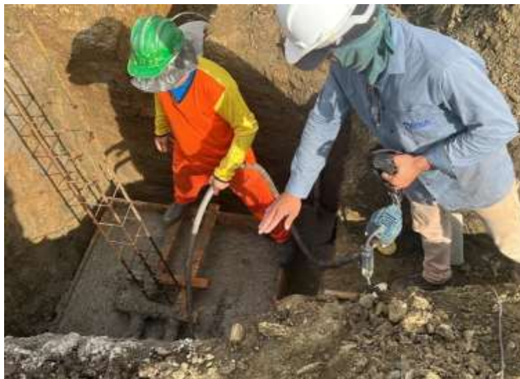
Figura 39 - Concretagem da base da sapata
