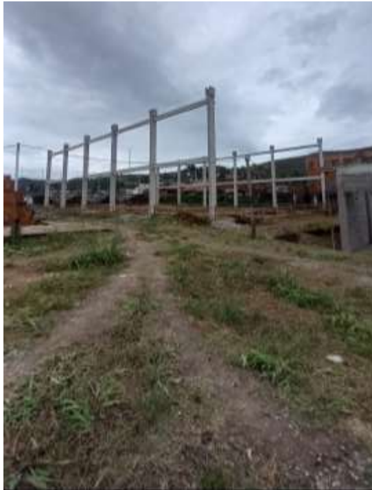
Figura 77 - Resultado da instalação do pré-moldado das laterais
