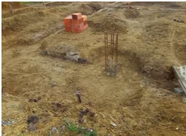
Figura 43 - Reaterro das valas
