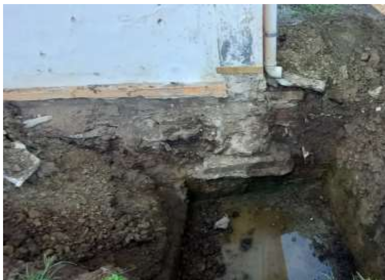
Figura 27 - Fundação existente da construção no bloco da administração
