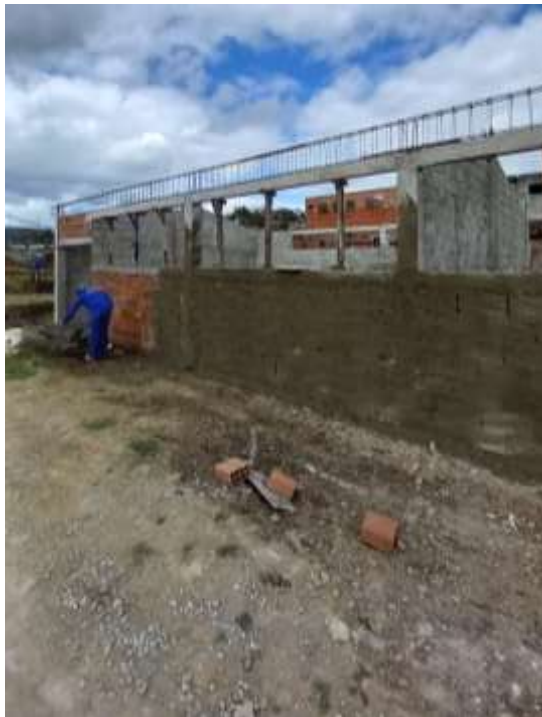
Figura 59 - Chapisco externo
