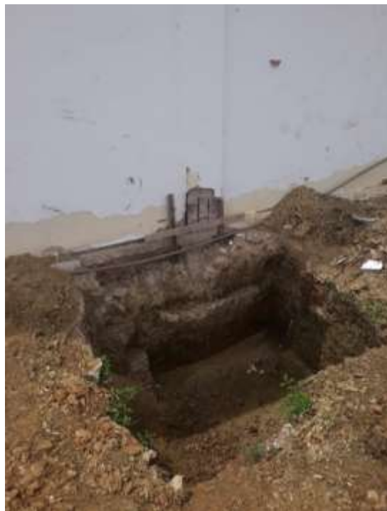
Figura 16 - Fundação existente da sala ao lado da biblioteca
