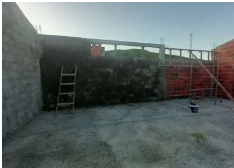
Figura 58 - Chapisco interno
