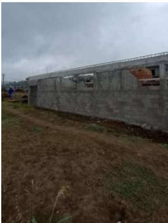
Figura 60 - Viga concretada
