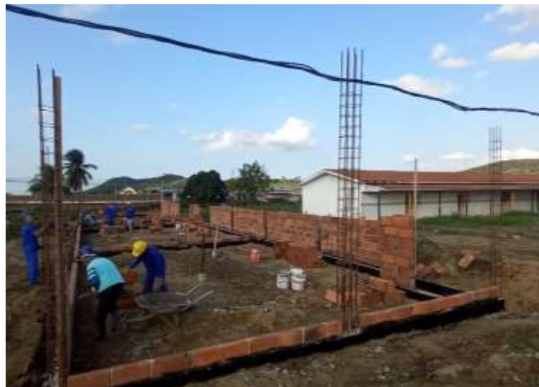
Figura 51 - Posicionamento das armaduras dos pilares
