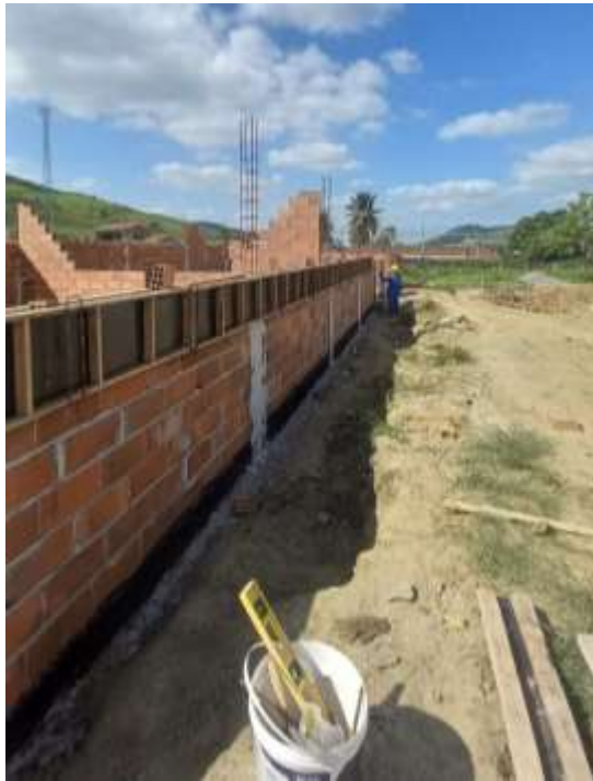
Figura 54 - Abafamento com fôrma de madeira para contra verga
