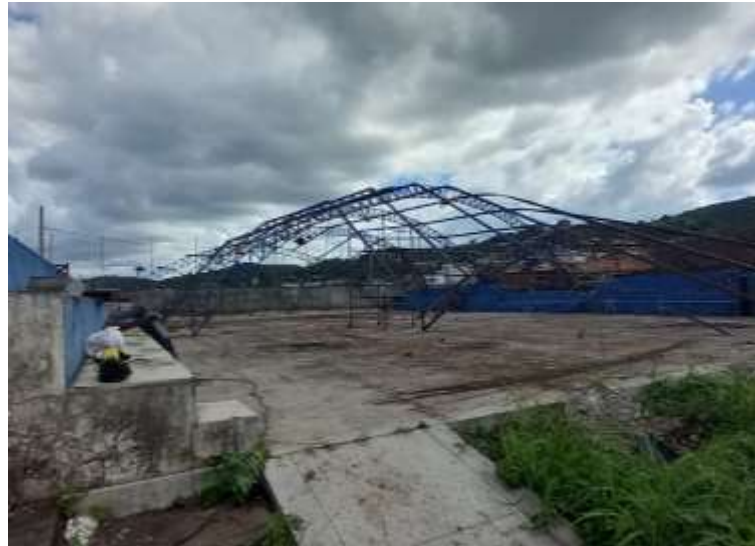
Figura 63 - Demolição do ginásio
