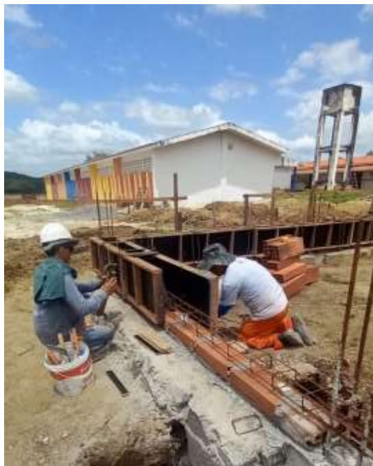
Figura 45 - Posicionamento do aço e fôrma de madeira da viga baldrame
