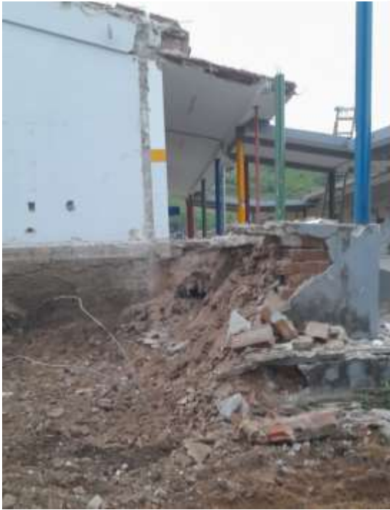
Figura 11 - Vista do aterro da secretaria demolida 1
