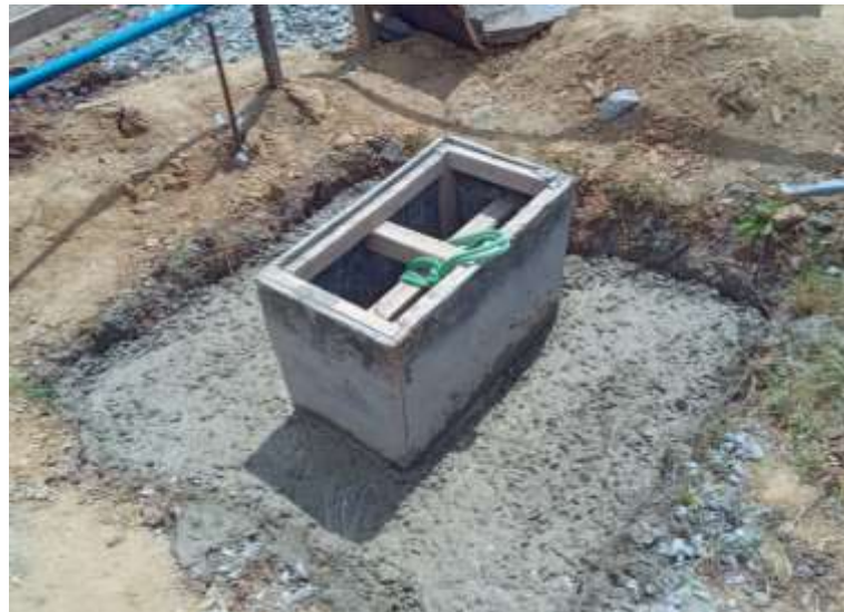
Figura 69 - Processo de concretagem (camada de concreto)
