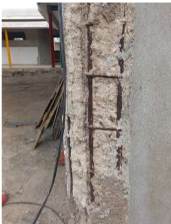
Figura 28 - Local onde será efetuado a recuperação estrutural
