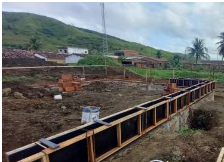
Figura 46 - Fôrma de madeira para a viga baldrame
