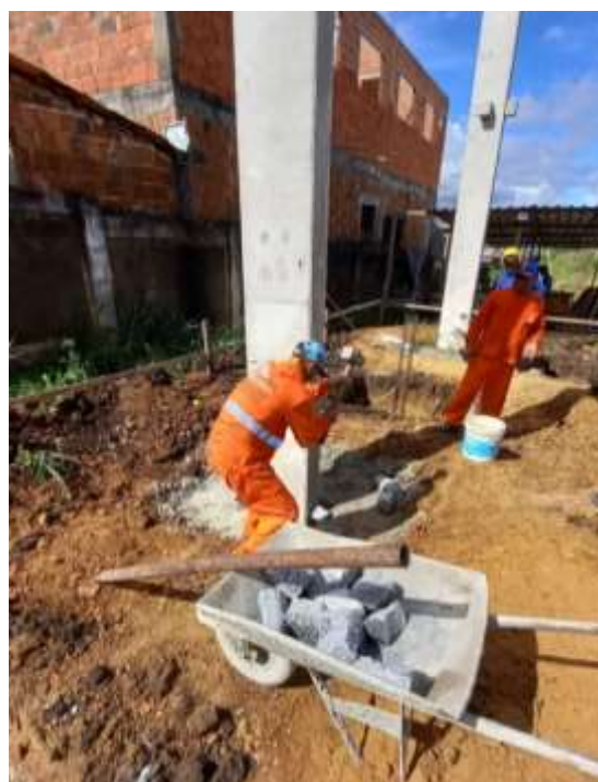
Figura 73 - Instalação de pilar pré-moldado (fixação com pedra rachão)
