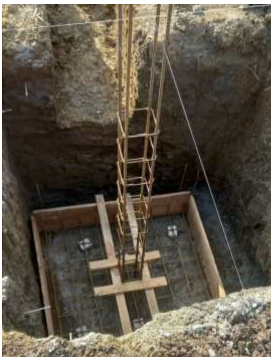
Figura 38 - Locação das sapatas
