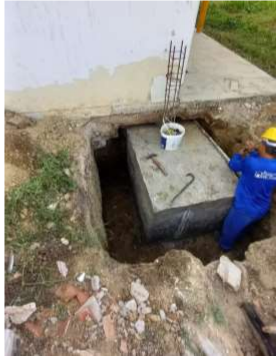
Figura 25 - Bloco de concreto finalizado - Biblioteca
