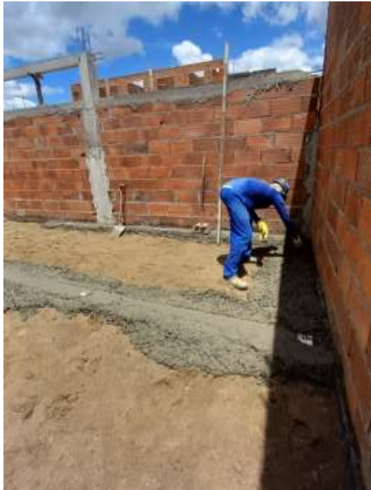
Figura 57 - Laje de impermeabilização para regularização de piso
