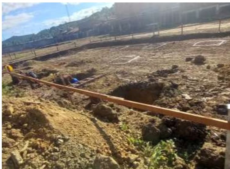
Figura 34 - Escavação das valas das sapatas
