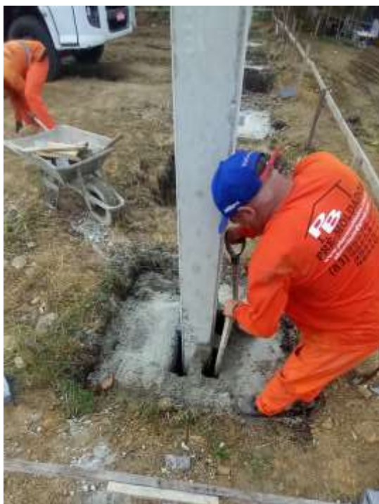
Figura 74 - Instalação de pilar pré-moldado (concretagem de vão)
