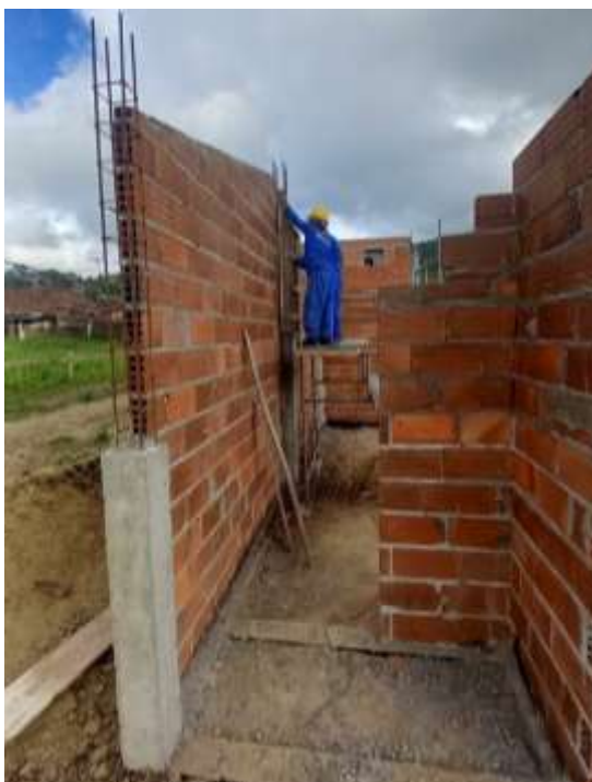
Figura 55 - Abafamento com fôrma de madeira para pilar (restante)
