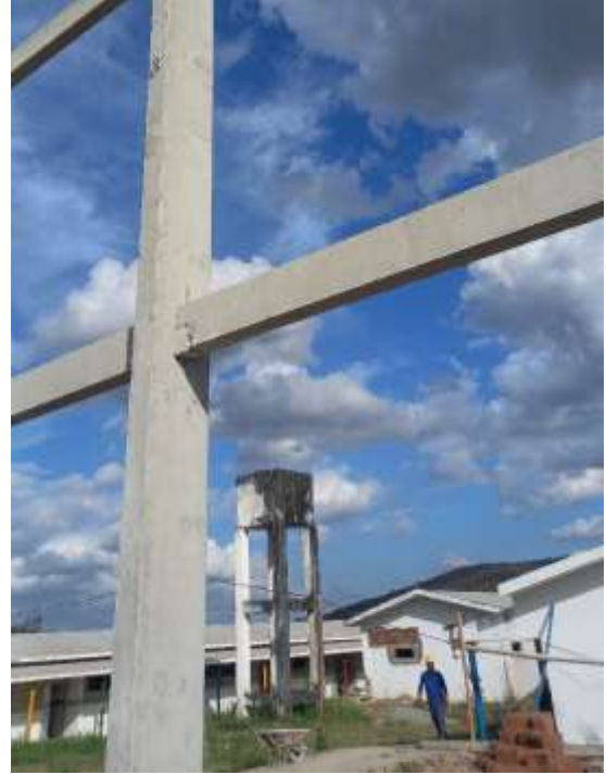
Figura 76 - Instalação de viga de contraventamento
