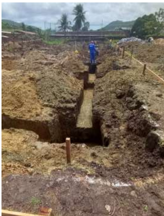
Figura 36 - Valas para a pedra rachão
