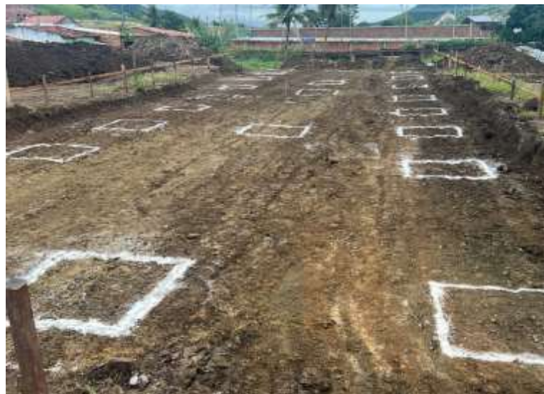
Figura 33 - Demarcação das sapatas
