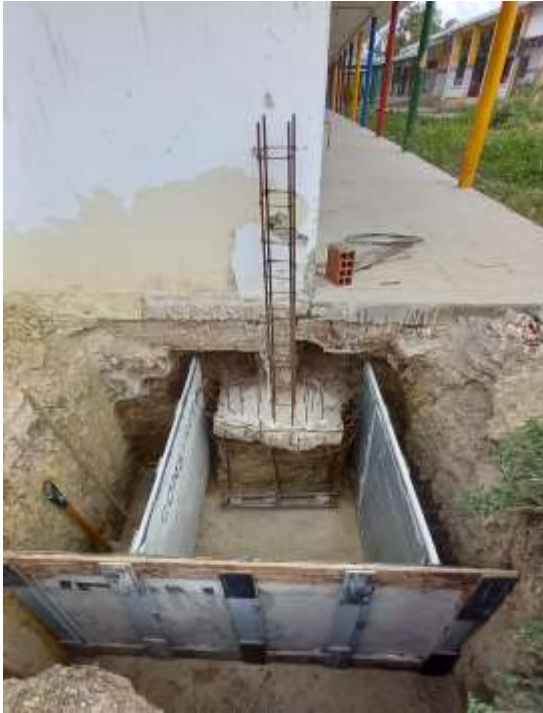
Figura 24 - Execução da fundação (biblioteca)
