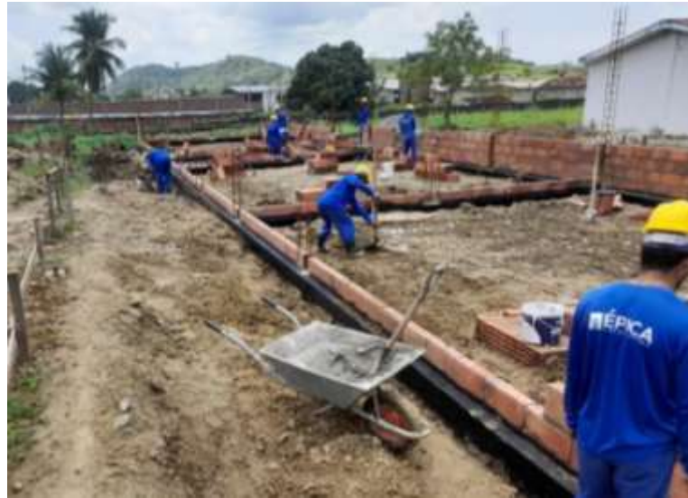
Figura 50 - Impermeabilização da viga baldrame
