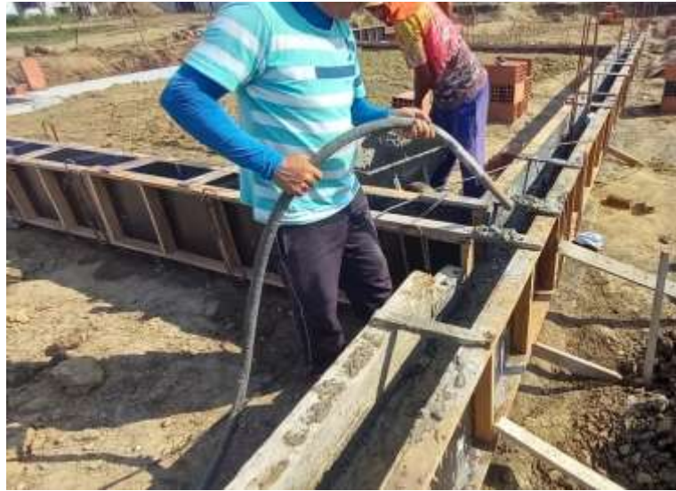
Figura 47 - Concretagem da viga baldrame
