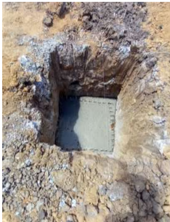
Figura 65 - Concretagem da base da sapata pré-moldada
