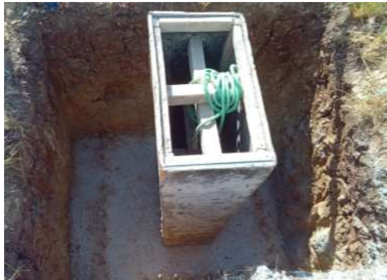
Figura 67 - Locação da fôrma no centro da sapata 2
