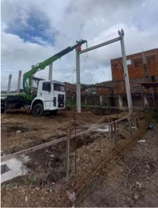
Figura 75 - Instalação de viga superior
