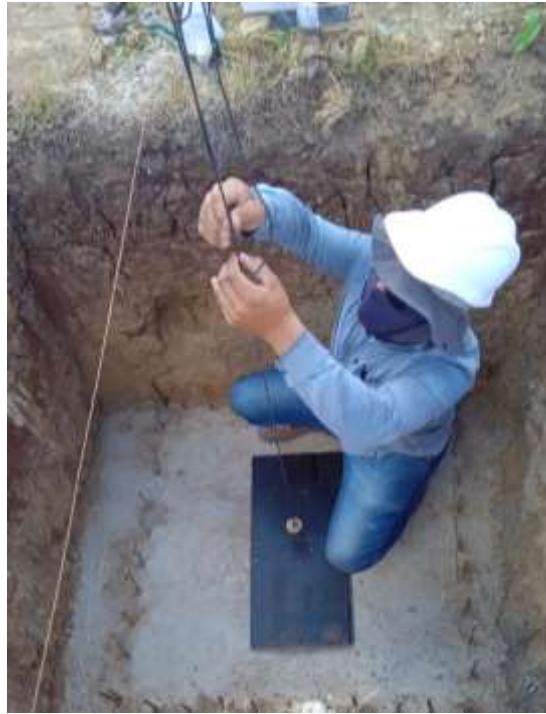
Figura 66 - Locação da fôrma no centro da sapata 1
