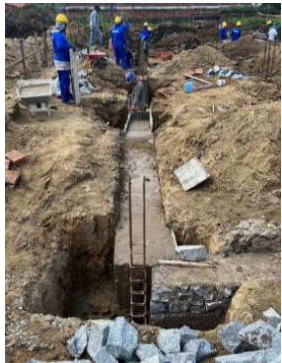
Figura 42 - Pedra argamassada
