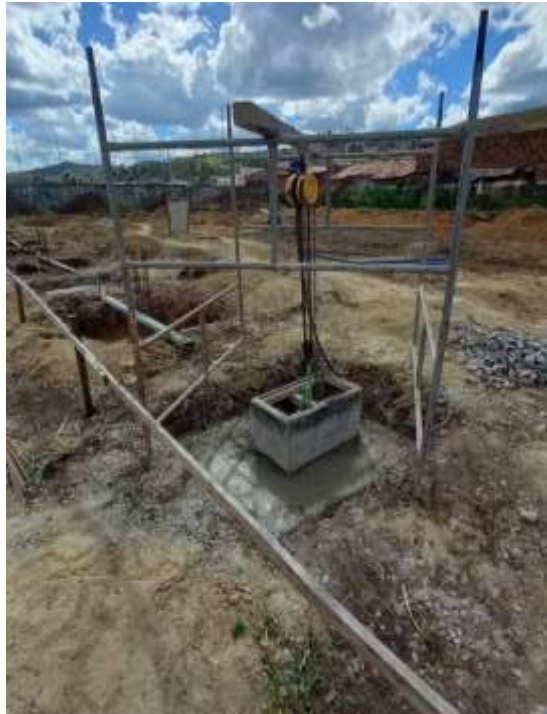
Figura 70 - Removendo a fôrma com talha manual
