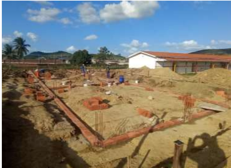
Figura 44 - Alvenaria de embasamento de 1 vez
