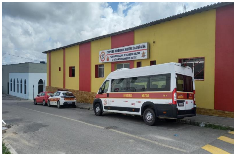
Figura 1: Referência da frente da edificação
