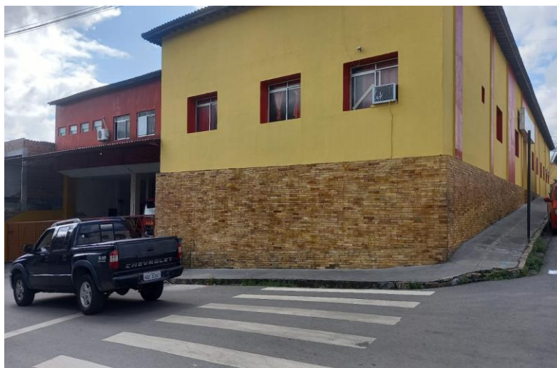
Figura 2: Referência lateral da edificação
