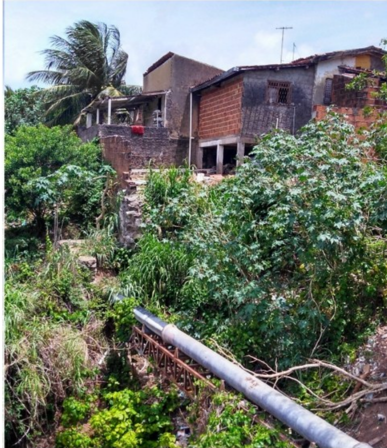
Figura 20: Voçoroca derrubou parte do muro de uma residência na área do parque. Fonte: Autor (2017)
