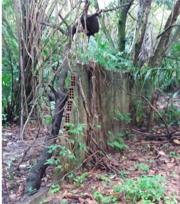
Figura 21: Muro construído dentro do parque. Fonte: Autor (2016)
