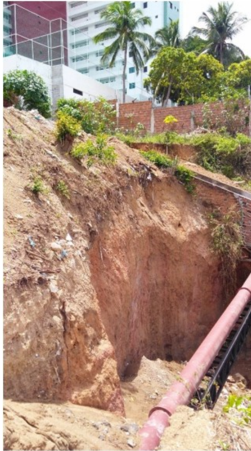
Figura 19: Área degradada onde observamos uma voçoroca a pouco mais de 50 metros de moradias. Fonte: Autor (2017)
