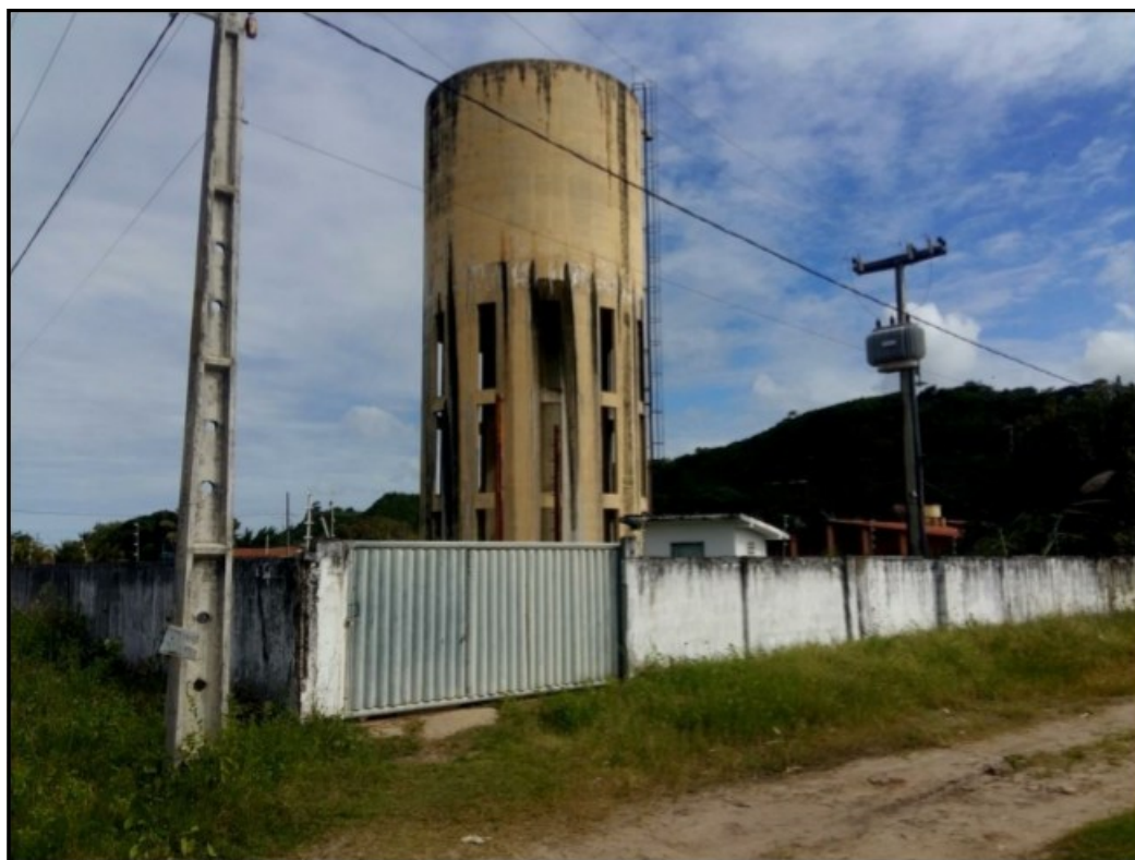
Foto 4 – Reservatório da SAAE instalado um pouco afastado do centro de Pitimbu.
