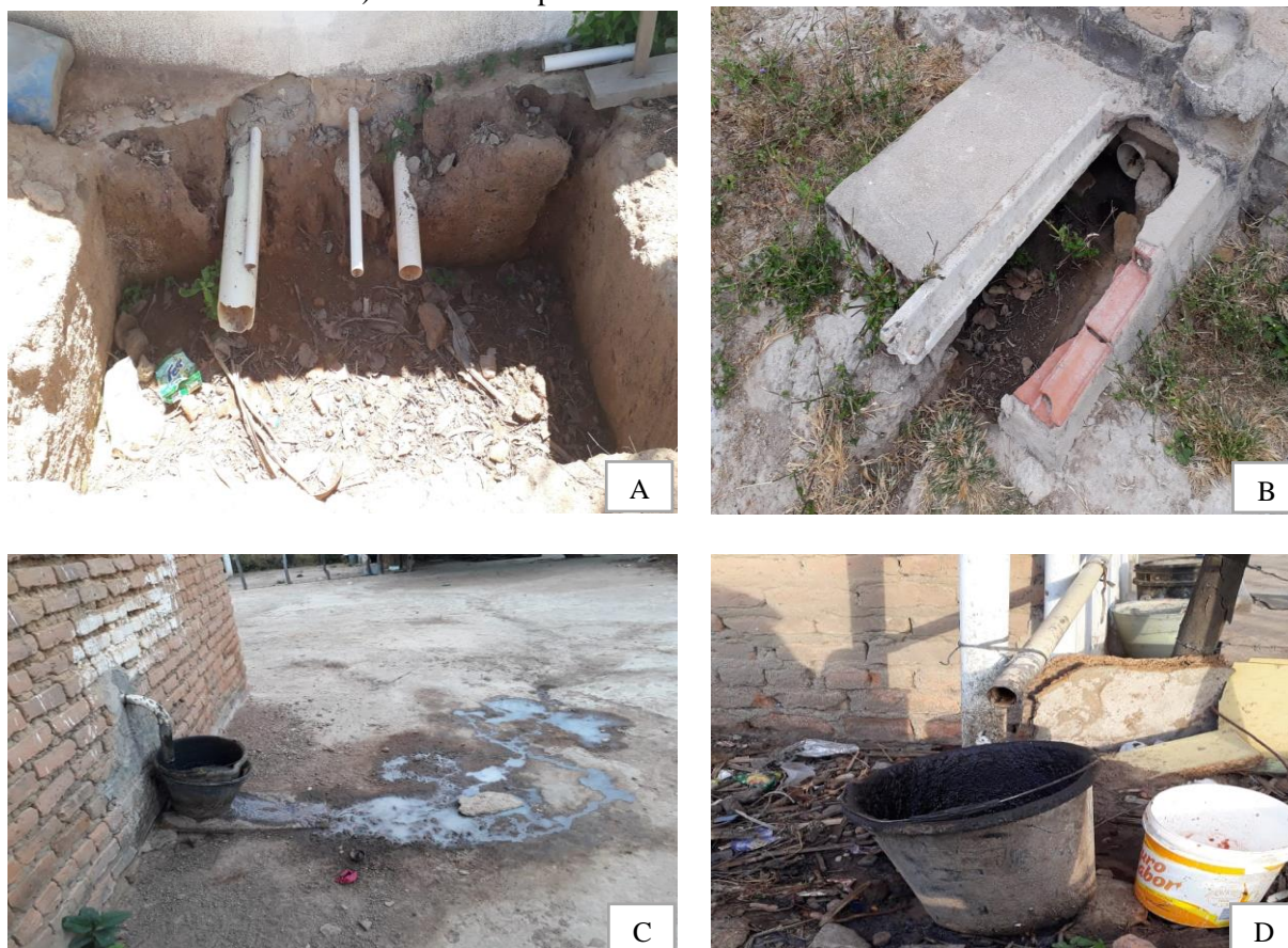
Figura 20 - Destino final dos efluentes gerados na comunidade: A) Fossa Negra; B) A céu Aberto; C) e D) efluentes da pia da cozinha recolhidos em baldes
