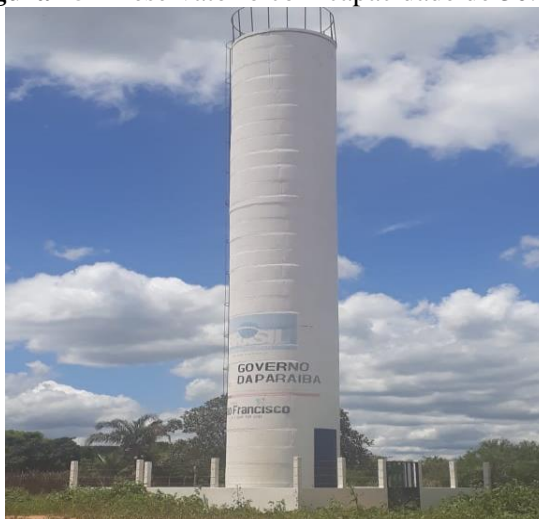
Figura 15 - Reservatório com capacidade de 30.000l
