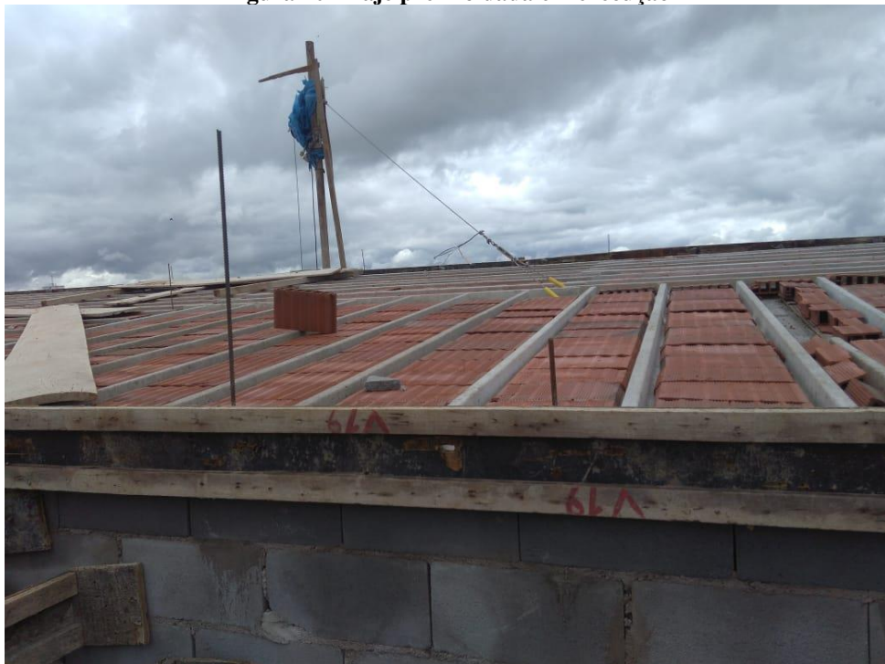
Figura 10 - Laje pré-moldada em execução
