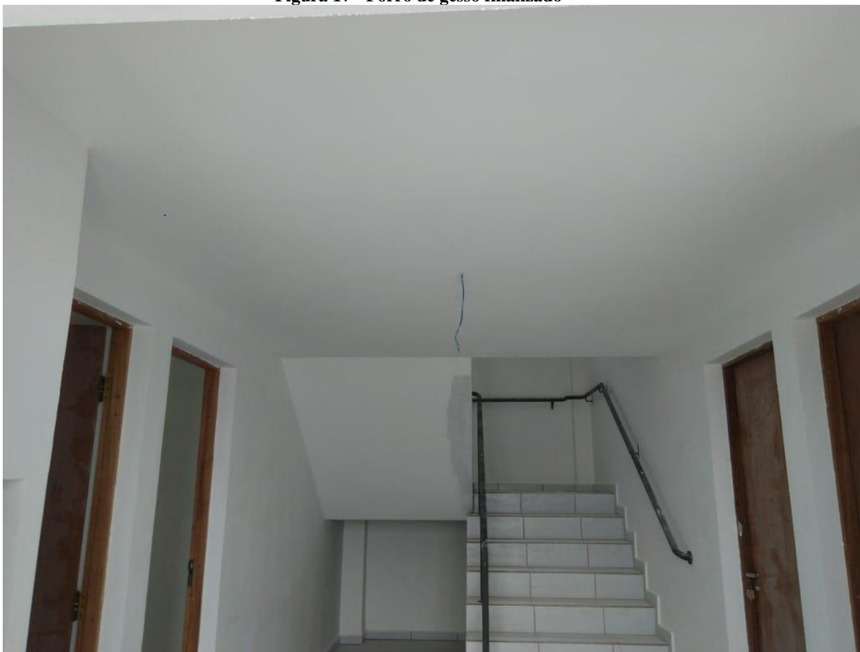
Figura 17 - Forro de gesso finalizado
