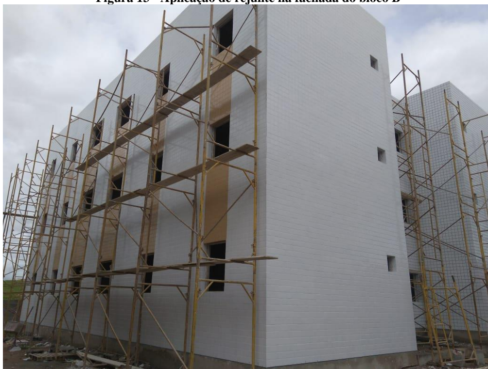
Figura 13 - Aplicação de rejunte na fachada do bloco B
