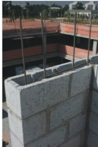
Figura 6- Armação vertical.
