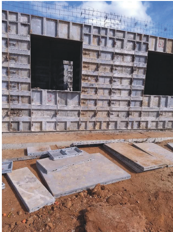
Figura 22- Fôrma metálica, área externa.
