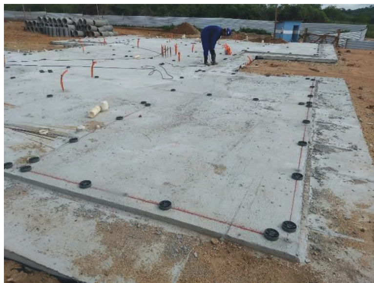
Figura 19- Marcação dos eixos de paredes.
