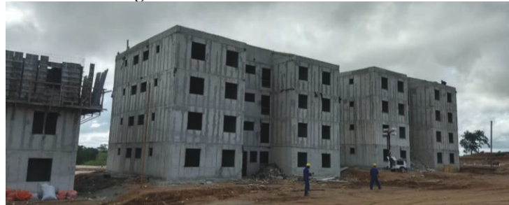
Figura 27- Acabamento de fachada.
