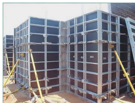
Figura 15- Fôrmas metálicas com compensado.
