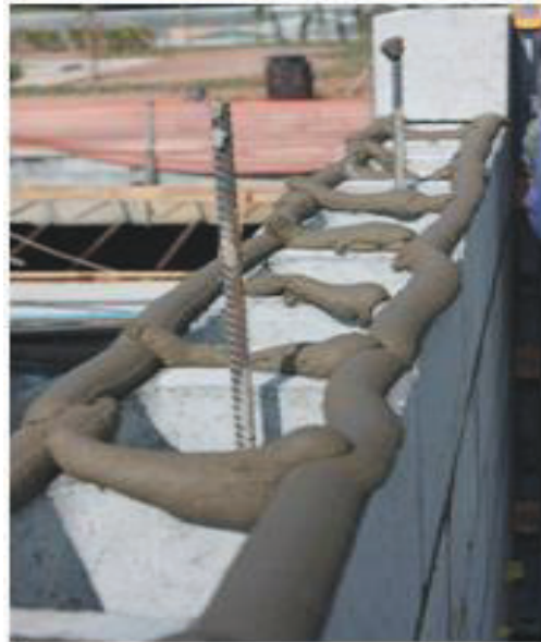
Figura 3- Argamassa de assentamento.
