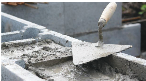
Figura 4- Aplicação de graute no preenchimento de blocos.
