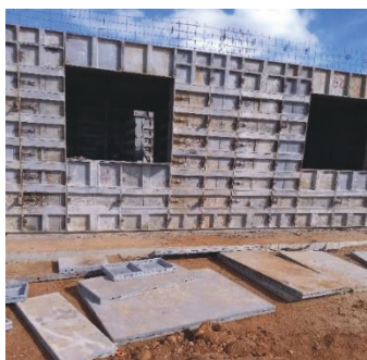
Figura 14- Fôrmas de alumínio.
