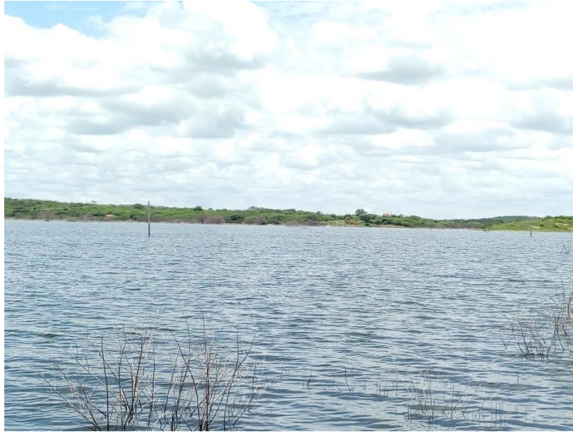
Imagem 18: Postes da rede elétrica, localizados dentro das águas da barragem.
