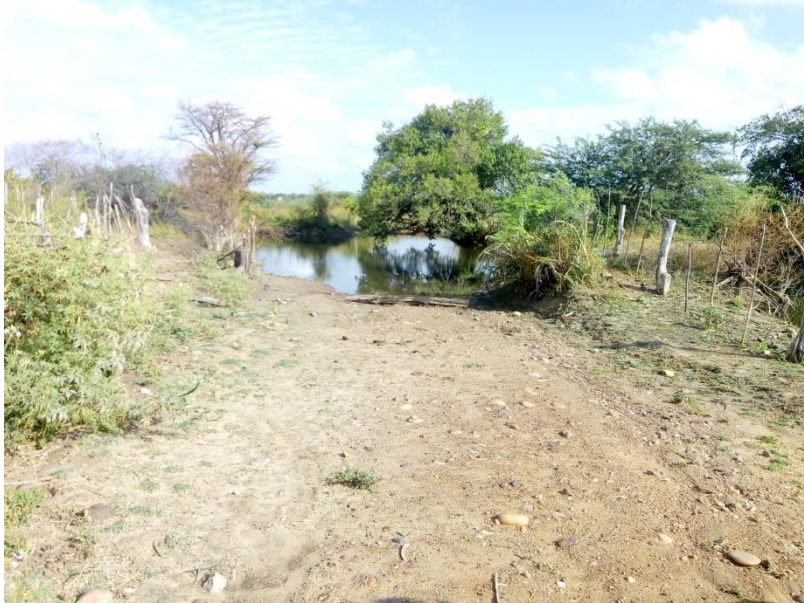
Imagem 13: Estrada obstruída pelas águas da barragem que interligava algumas comunidades entre o município de Tuparetama e São José do Egito.
