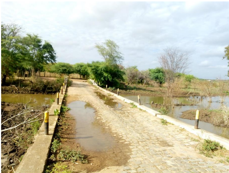
Imagem 14: Passagem que interliga a zona rural do município de Tuparetama a zona rural do município da Ingazeira que ficará submersa pelas águas.
