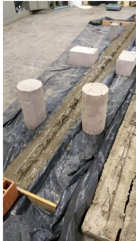
Figura 14: Execução das vigotas usadas na laje treliçada
