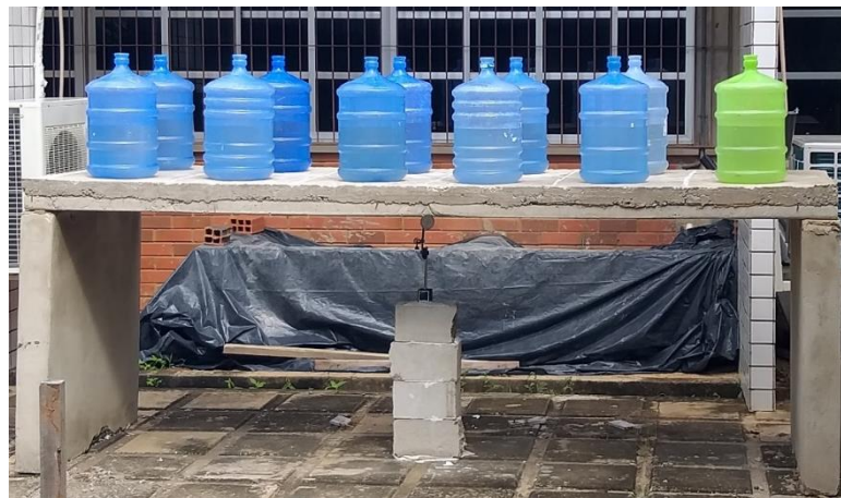
Figura 19: Garrafões colocados sobre a laje
