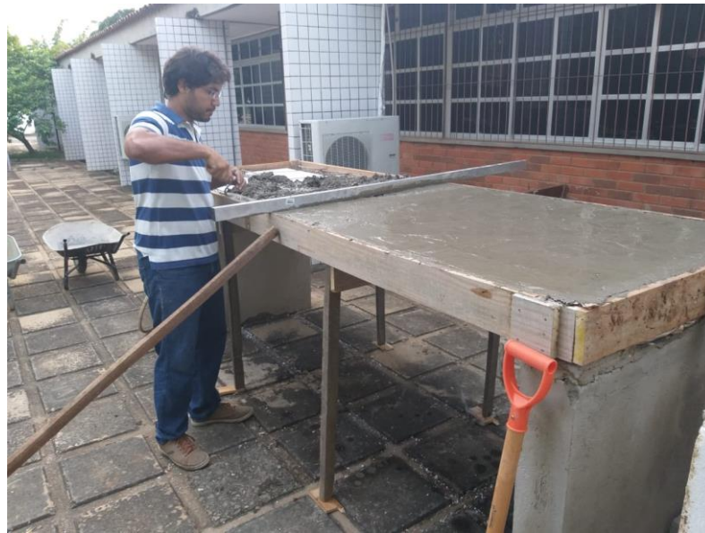
Figura 16: Adensamento e acabamento da laje
