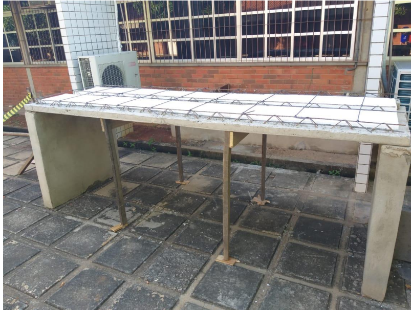
Figura 15: Vigotas apoiadas nas paredes com os blocos de EPS e armadura de distribuição
