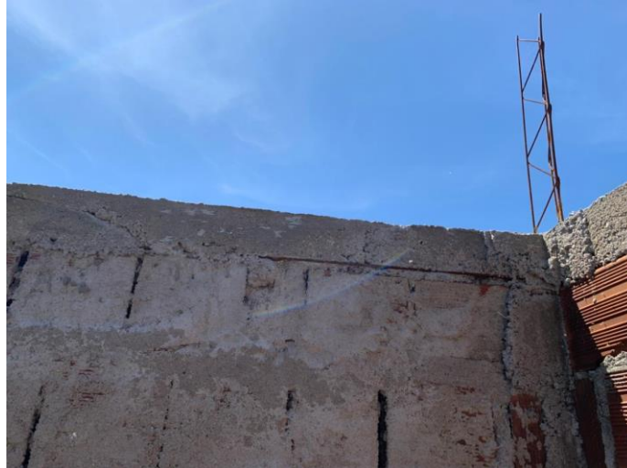
Figura 28 – Cobrimento do concreto.
