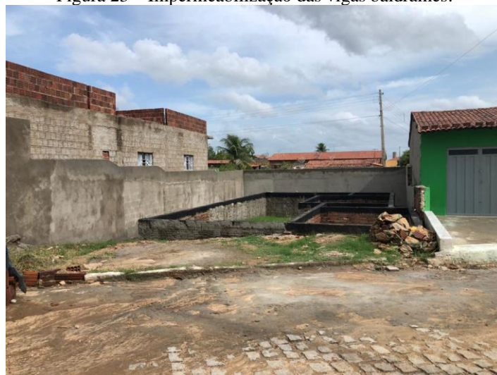
Figura 23 – Impermeabilização das vigas baldrame.
