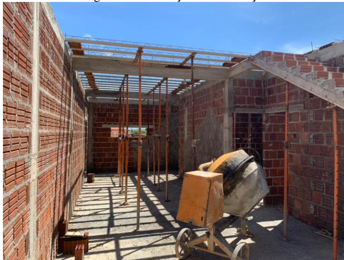
Figura 24– Execução da construção
