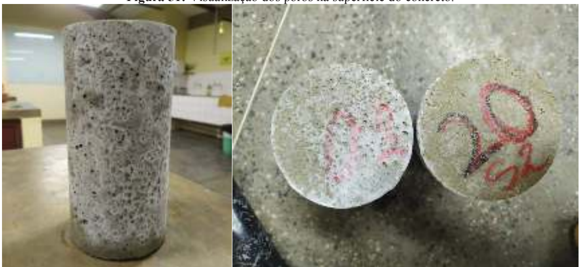
Figura 51: Visualização dos poros na superfície do concreto.
