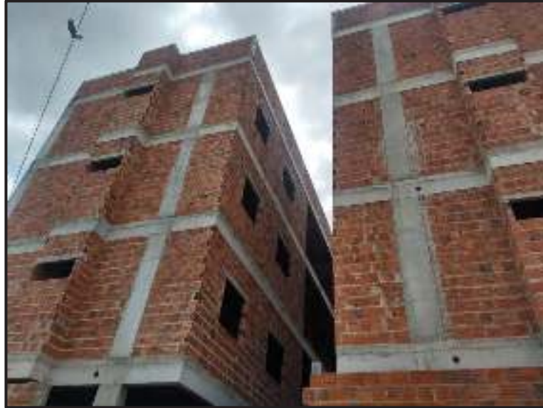
Figura 29 - Duas torres da construção 01
