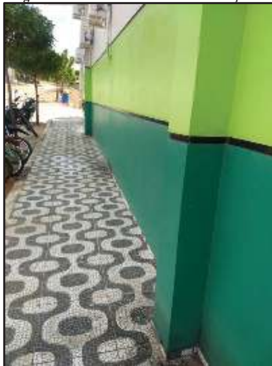
Figura 30 - Pilares externos da construção 02
