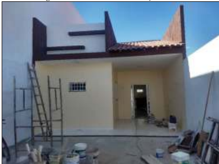
Figura 23 - Fachada da construção 04
