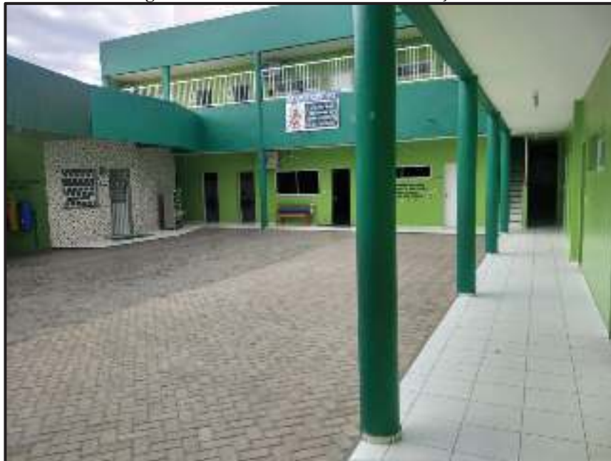
Figura 31 - Pilares internos da construção 02
