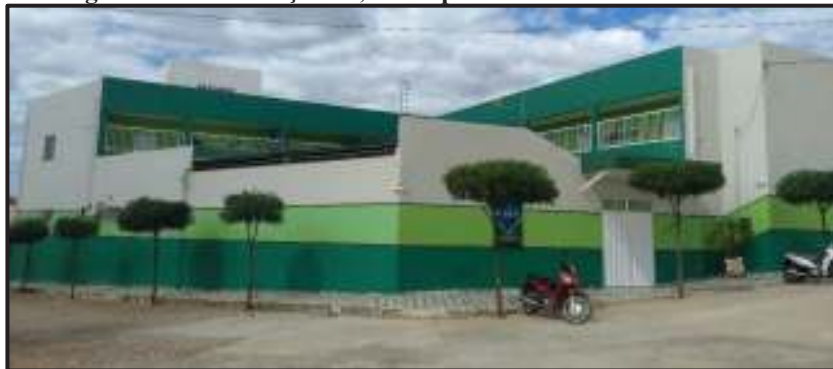
Figura 21 - Construção 02, na responsabilidade do construtor B
