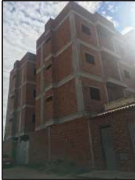
Figura 20 – Construção 01, na responsabilidade do construtor A
