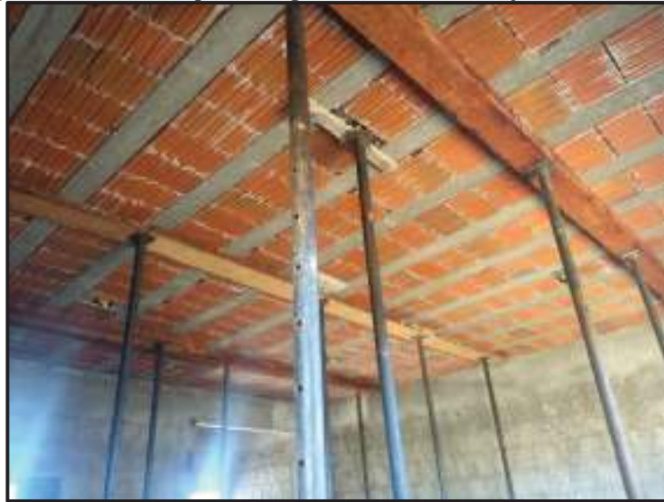
Figura 26 - Escoras espaçadas igualmente em laje na construção 03
