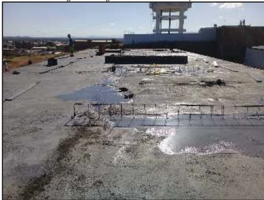
Figura 32 - Vigas invertidas da construção 03
