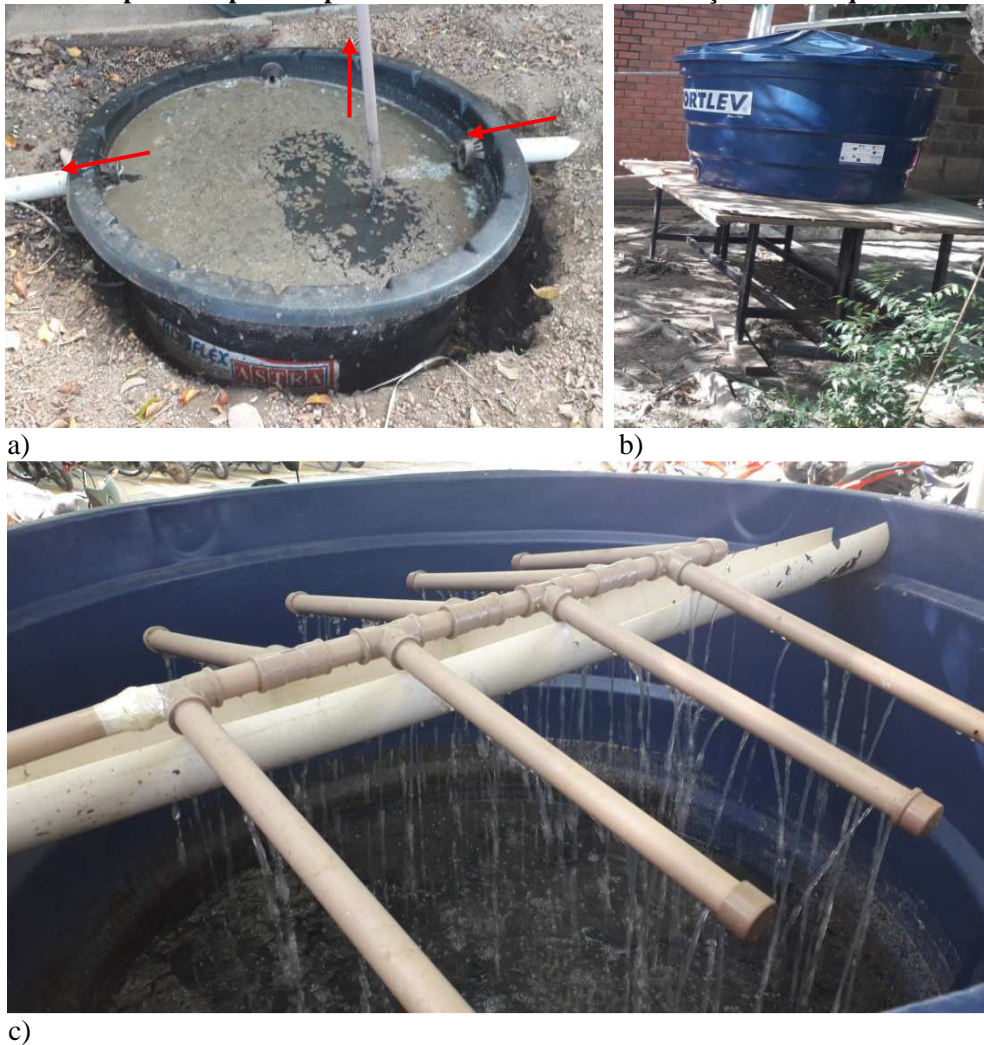
Figura 3: a) Reservatório enterrado - R1; b) Reservatório elevado - R2; c) Tubo Ø25mm em formato de espinha de peixe implantada no R2 ao final da tubulação de recalque.
