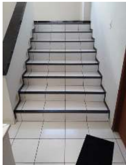
Figura 12: Escadas da edificação
