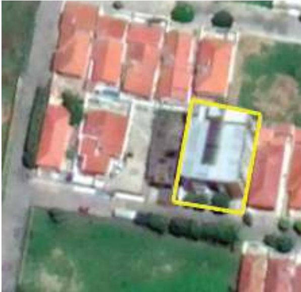
Figura 5: Vista aérea da edificação
