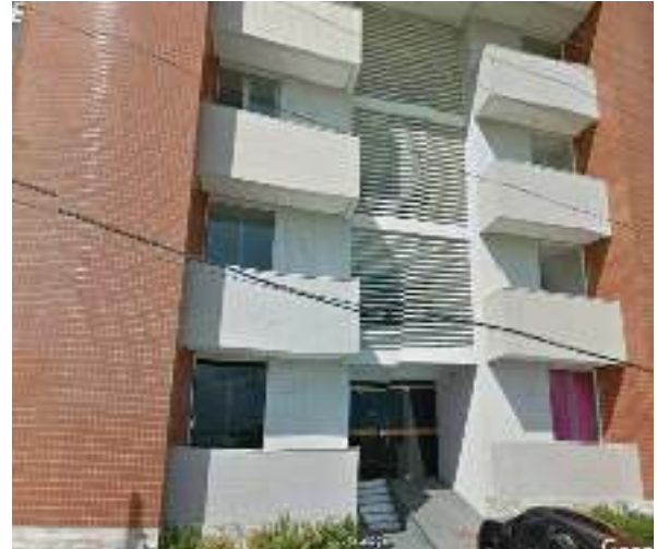
Figura 6: fachada da edificação
