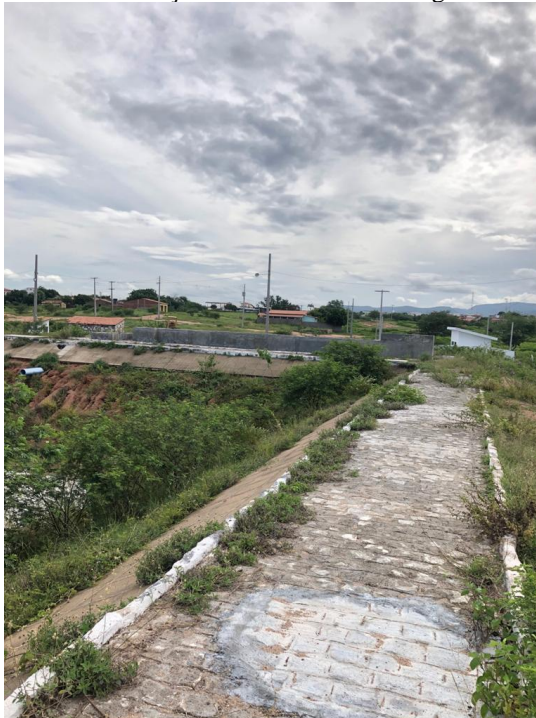
Figura 5 – Vista 1 da Estação de Tratamento de Esgoto de Triunfo – PB.
