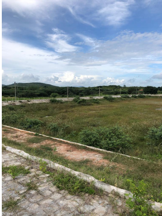
Figura 6 – Vista 2 da Estação de Tratamento de Esgoto de Triunfo – PB.
