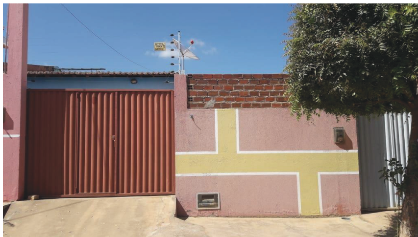
Figura 9 – Reforma para aumentar a altura do muro da fachada
