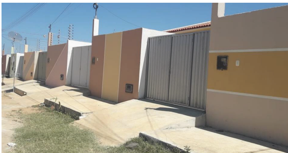
Figura 3- Construção de casas geminadas – Loteamento Crystal, Cajazeiras (PB)
