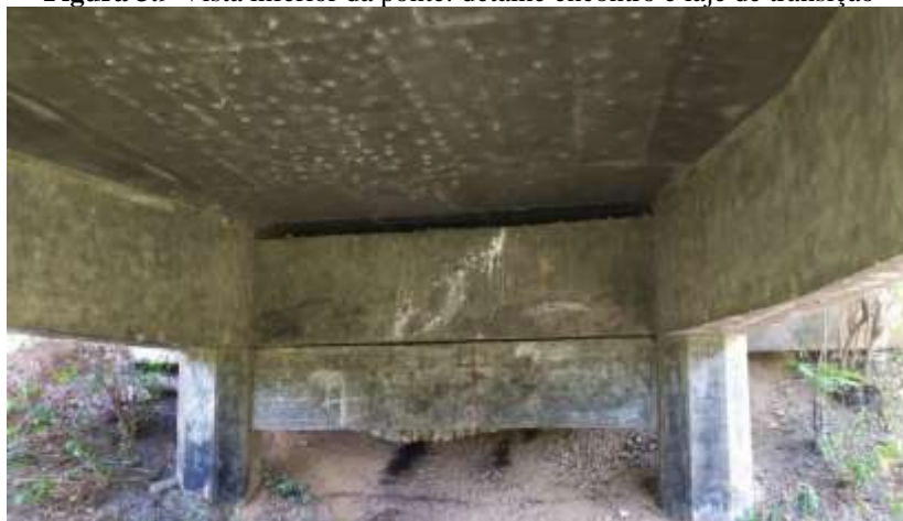
Figura 3.9 Vista inferior da ponte: detalhe encontro e laje de transição
