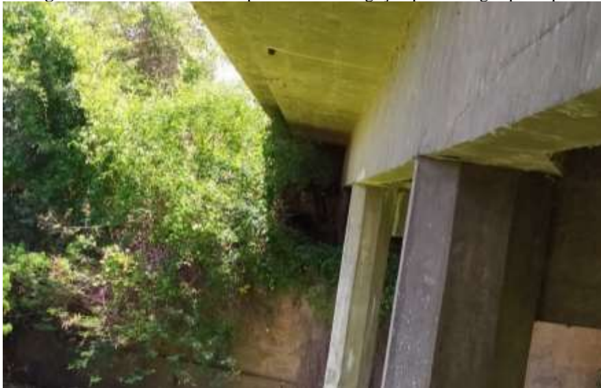
Figura 3.10 Vista inferior da ponte: detalhe ligação pilares/vigas principais
