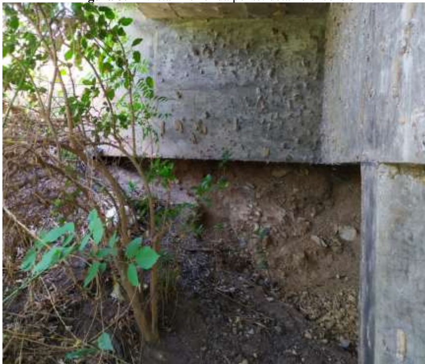
Figura 3.11 Vista inferior da ponte: detalhe encontro
