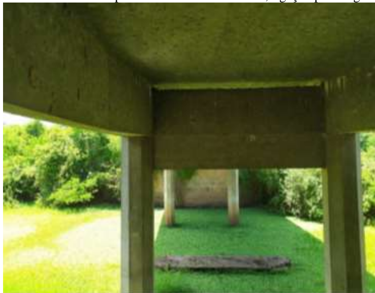
Figura 3.9 Vista inferior da ponte: detalhe encontro e laje de transição
