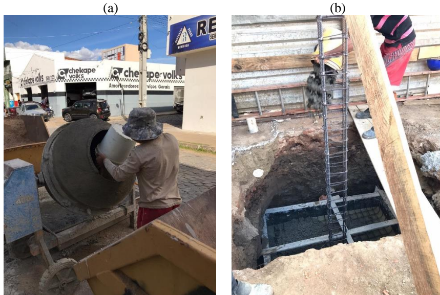
Figura 12 - (a) Mistura do concreto na betoneira e (b) Lançamento do concreto na estrutura – Obra 03.
