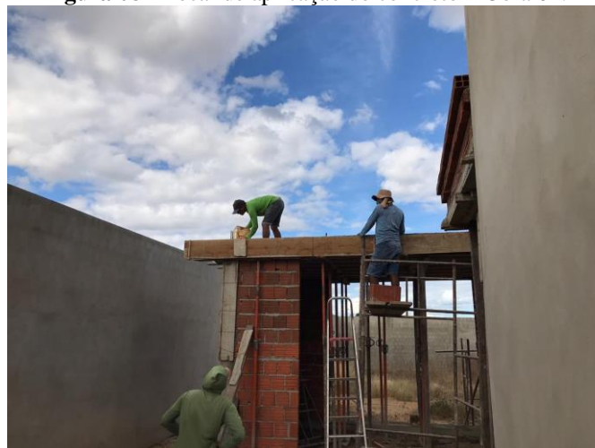
Figura 08 - Local de aplicação do concreto – Obra 02.
