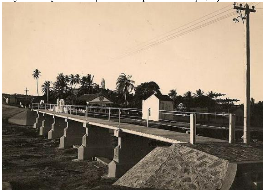
Figura 9 - Sangradouro do Açude Grande depois da reconstrução, Cajazeiras – PB.
