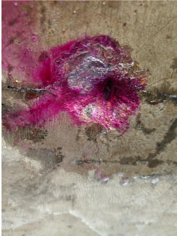
Figura 26 - Ensaio de profundidade de carbonatação na face inferior da laje Estrutura II.
