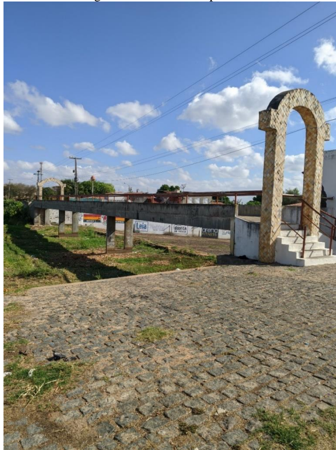
Figura 17 - Estrutura I: passarela.
