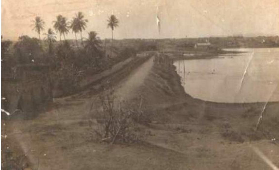
Figura 8 - Açude Grande depois da reconstrução (Barragem principal), Cajazeiras - PB.
