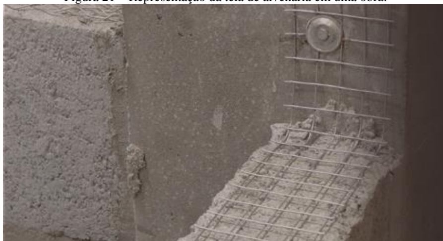
Figura 21 – Representação da tela de alvenaria em uma obra.
