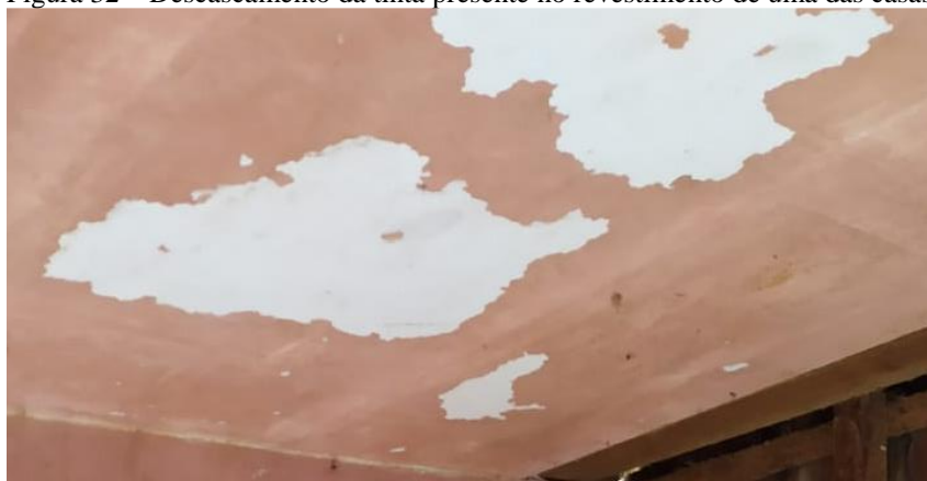
Figura 32 – Descascamento da tinta presente no revestimento de uma das casas.
