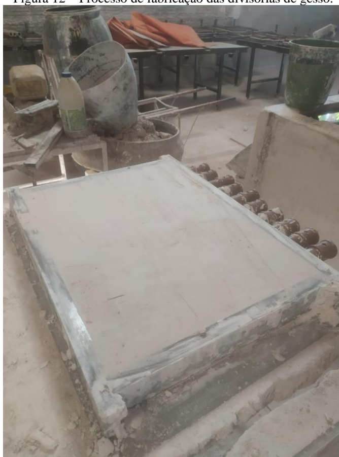
Figura 12 – Processo de fabricação das divisórias de gesso.
