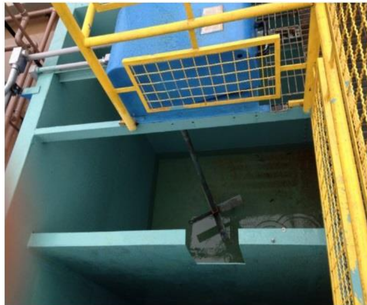
Figura 13 - Floculador mecânico
