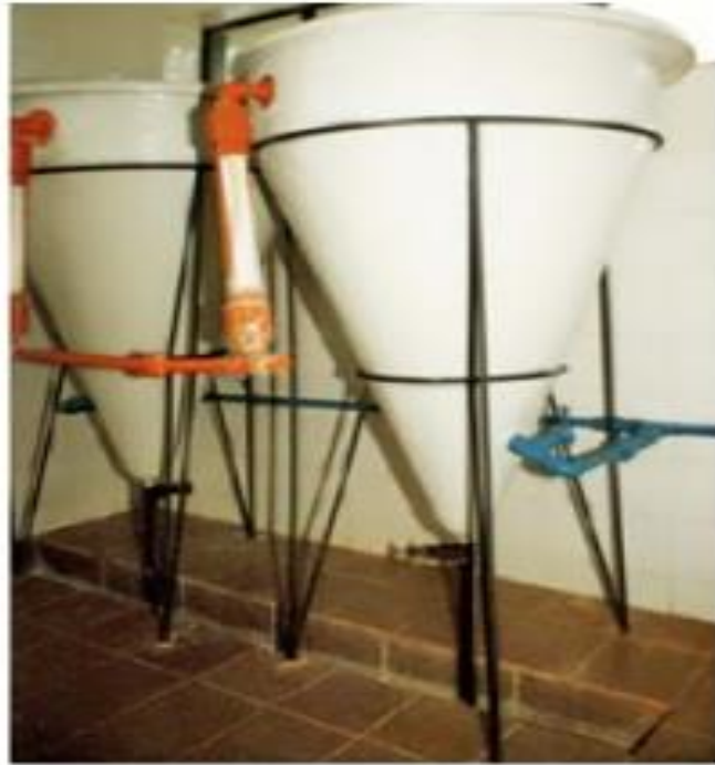
Figura 24 - Cone de saturação para dosagem de flúor
