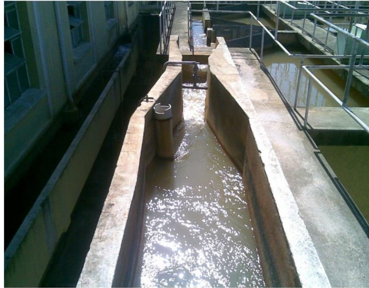
Figura 5 - Calha Parshall
