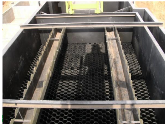
Figura 18 - Decantador com módulos tubulares
