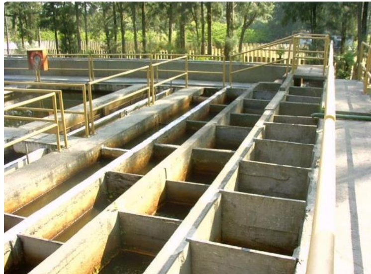
Figura 9 - Floclador de chicanas com fluxo vertical
