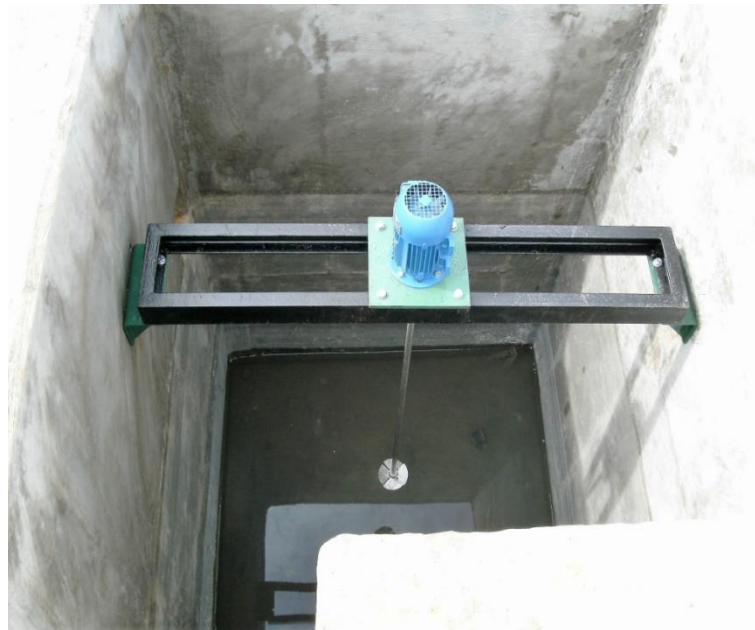
Figura 7 - Misturador rápido de eixo vertical
