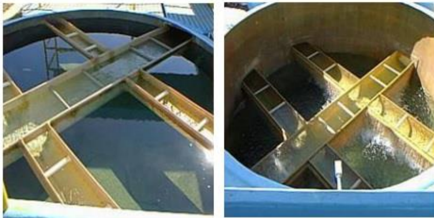
Figura 40 - Filtro Ascendente e Descendente em unidades separadas
