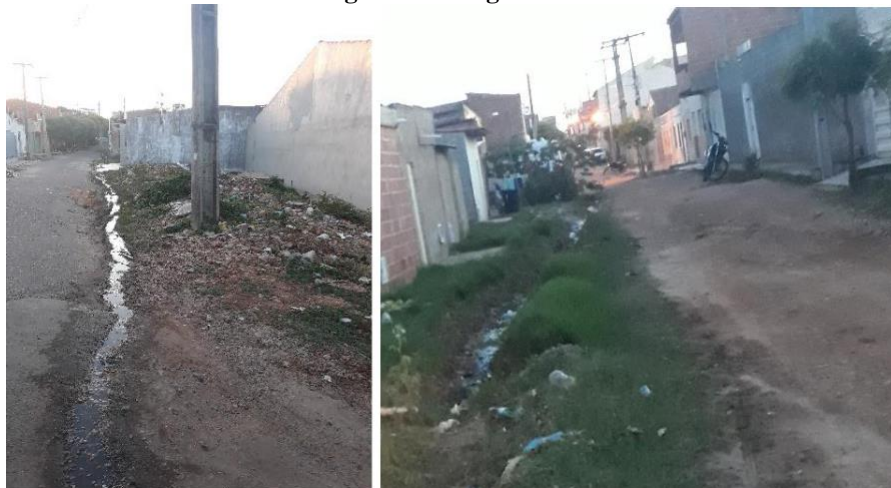
Figura 10 – Esgoto a céu aberto
