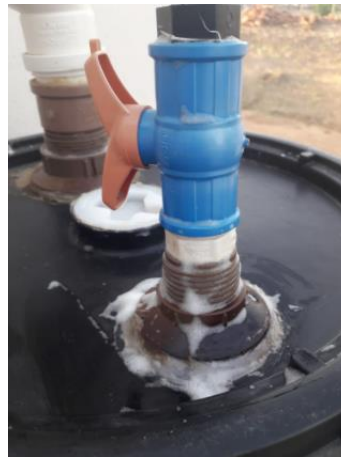
Figura 18 - Vazamento no flange.
