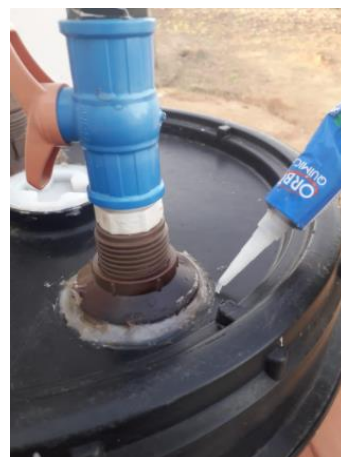
Figura 19 - Reparo com cola de silicone.
