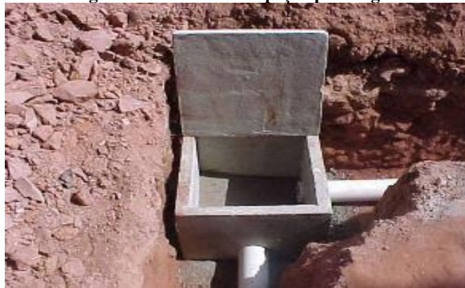
Figura 16 – Caixa de Inspeção para esgoto
