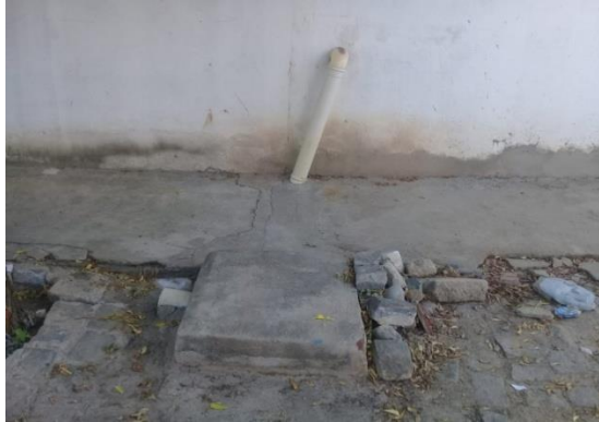
Figura 15 – Canalização para lançamento de efluentes na rua
