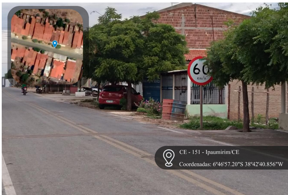
Figura 9 – Sinalização vertical encoberta por arborização.
