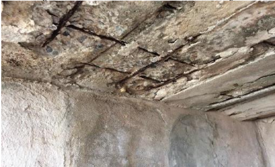
Figura 11 - Corrosão de armaduras em fundo de caixa d'água.
