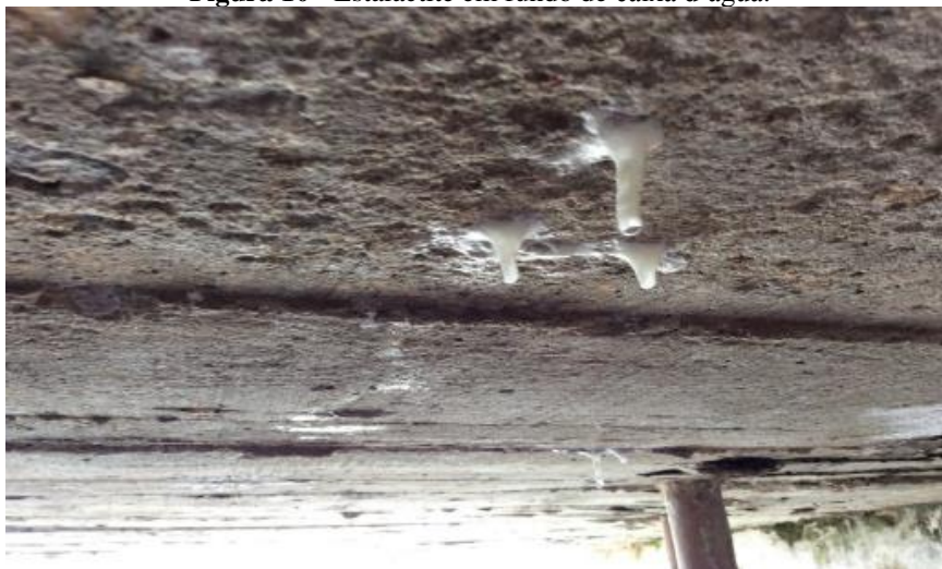
Figura 10 - Estalactite em fundo de caixa d'água.
