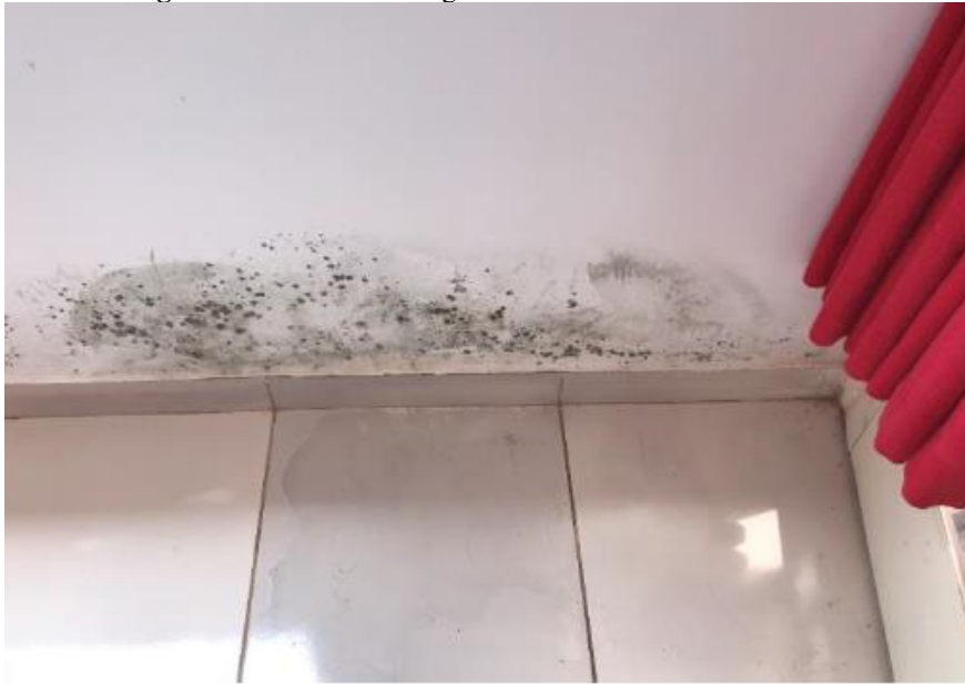
Figura 4 – Manchas e fungos devido à umidade ascensional.
