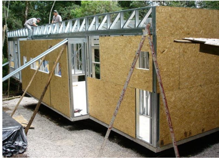
Figura 7 – Aplicação das placas de OSB na vedação de alvenarias.
