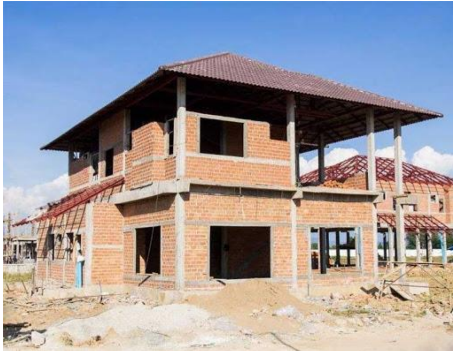
Figura 1 – Residência feita em alvenaria convencional e concreto armado.
