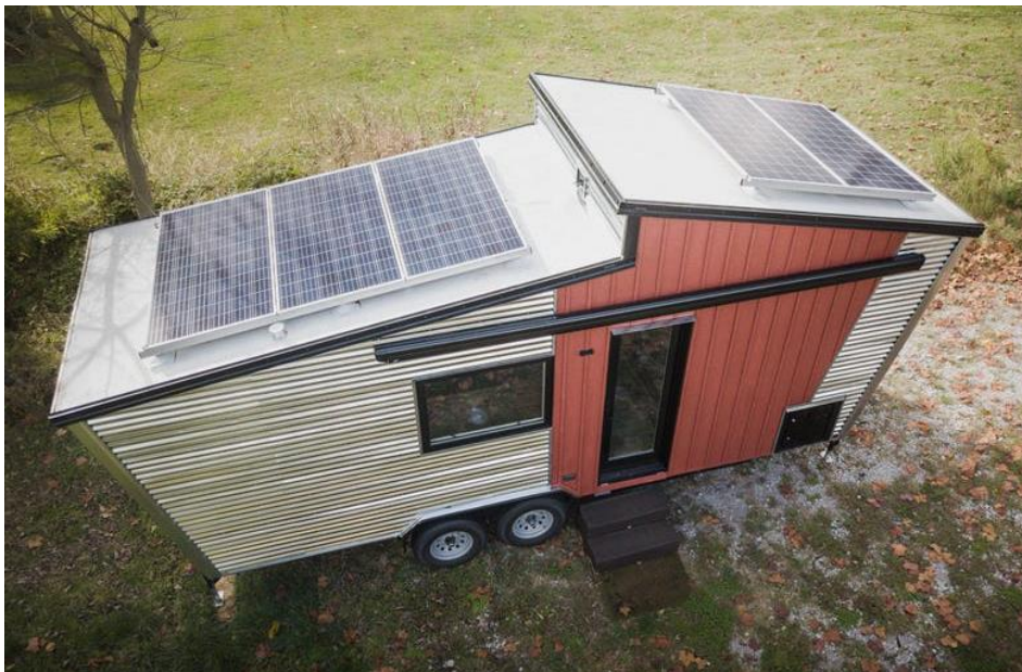
Figura 10 – Tiny house com sistema fotovoltaico instalado.
