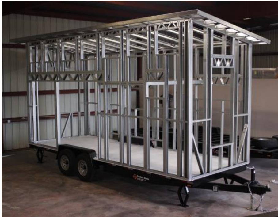
Figura 5 – Tiny house feita em steel frame .
