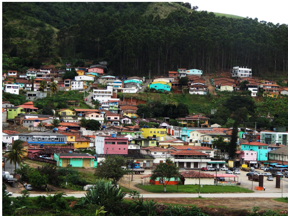
Figura 5: Pátio da Ceasa, São Vicente Férrer - PE
