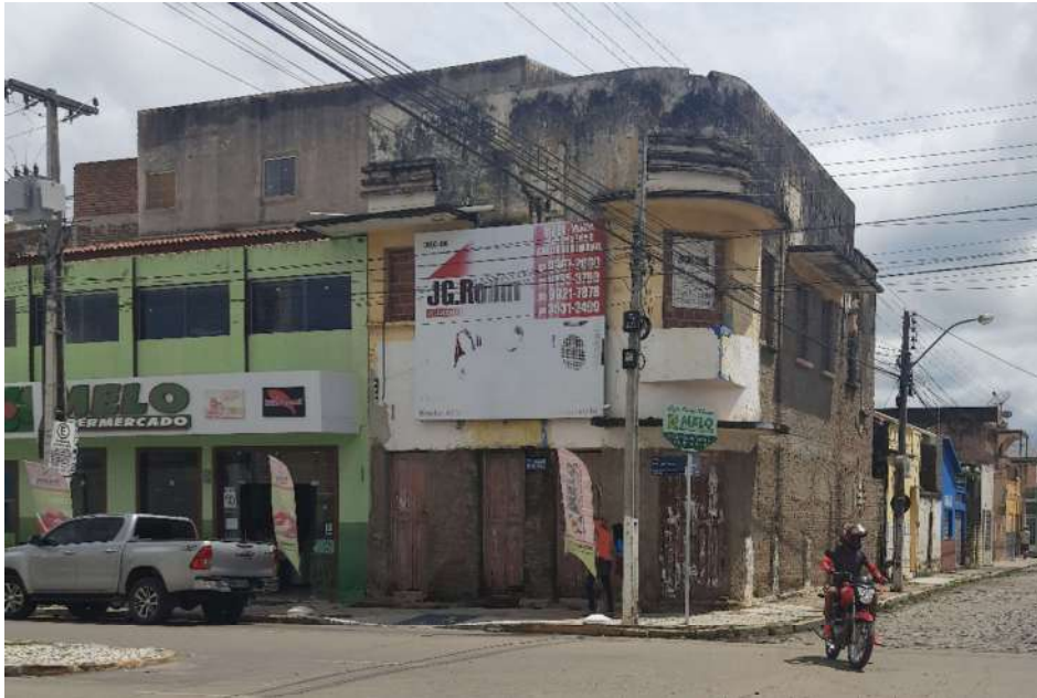
Figura 5 – Edifício em suas condições atuais de conservação, foto de abril de 2021.
