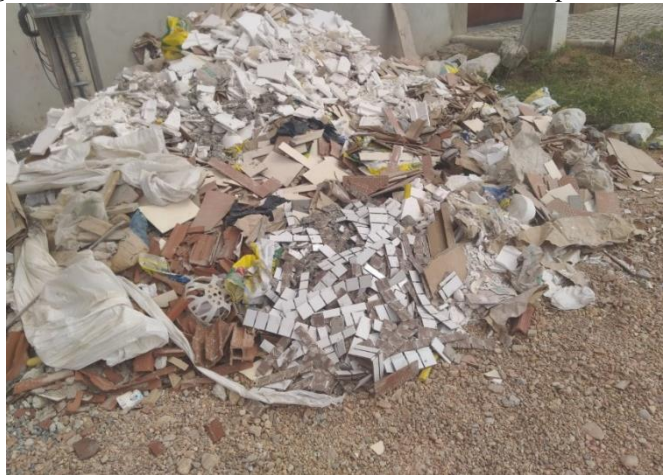
Figura 25: Resíduos misturados na área externa do empreendimento.
