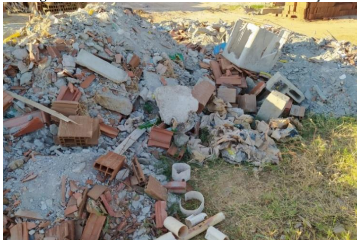
Figura 32: Resíduos acumulados ao redor da construção.
