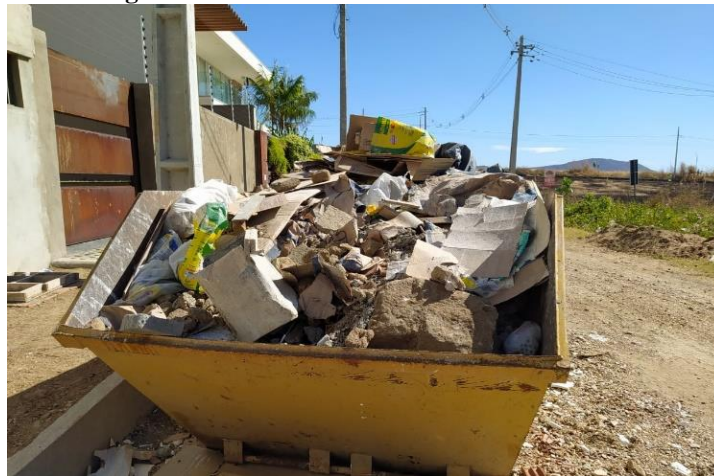
Figura 34: Acondicionamento final dos resíduos.
