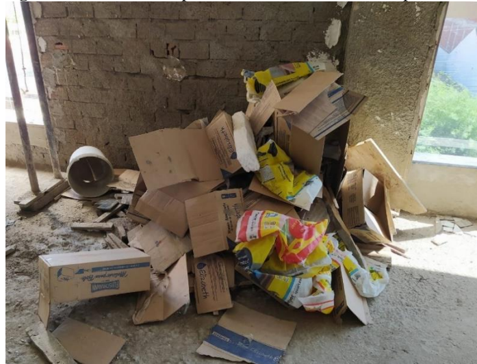
Figura 14: Resíduos empilhados em áreas isoladas do pavimento.
