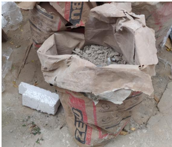
Figura 48: Saco de cimento usado para o acondicionamento dos RCC.
