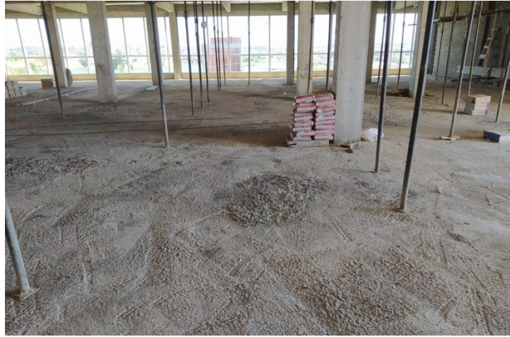
Figura 12: Limpeza na obra C.
