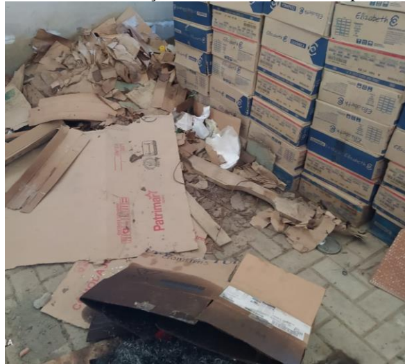
Figura 27: Restos da tubulação de incêndio próximo a pilha de papelão.
