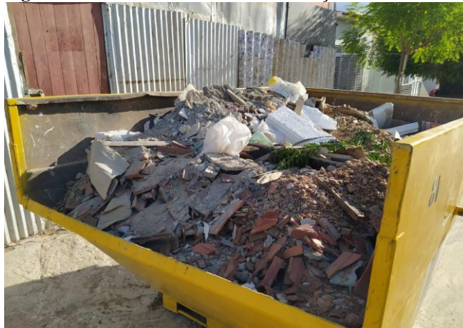
Figura 40: Resíduos acondicionados na caçamba estacionária.
