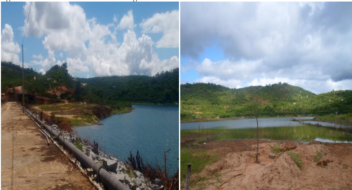
Figuras 7 e 8 - Erosão acentuada nas margens e acúmulo de sedimentos no leito do reservatório Tavares II.
