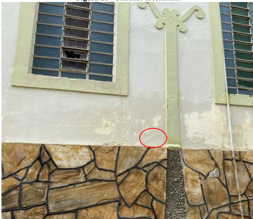
Figura 28 - Umidade ascendente.
