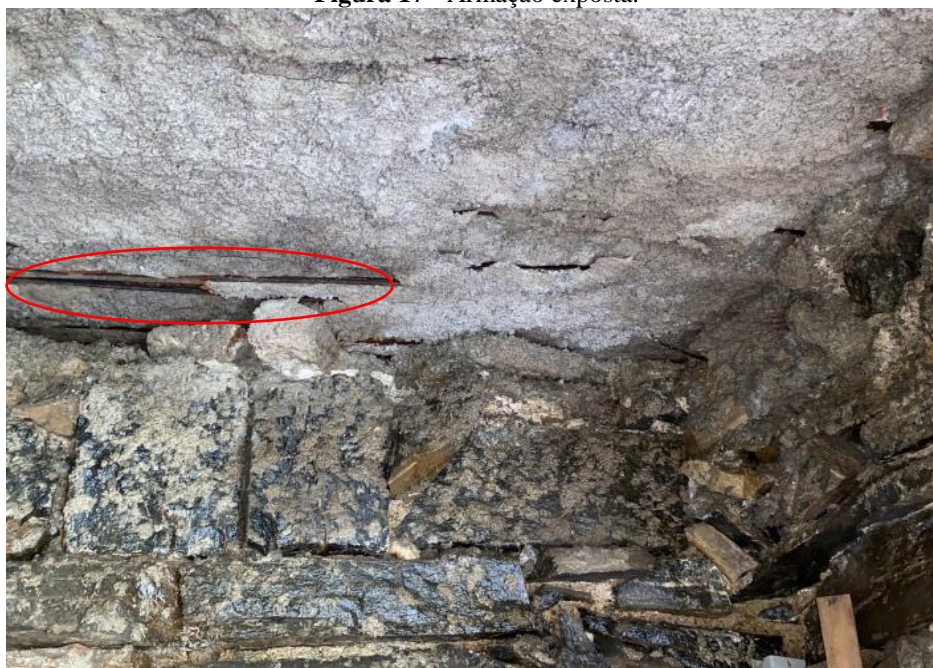
Figura 17 - Armadura exposta.
