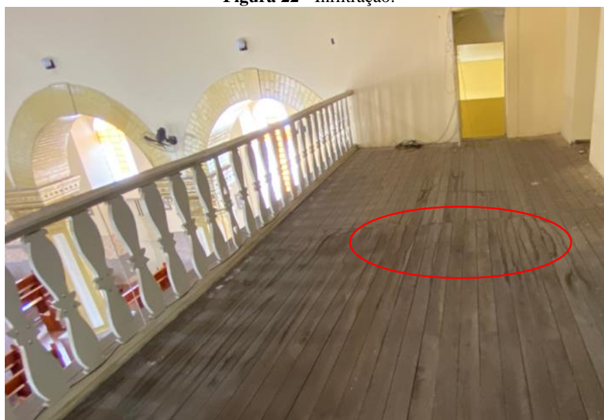
Figura 22 - Infiltração.
