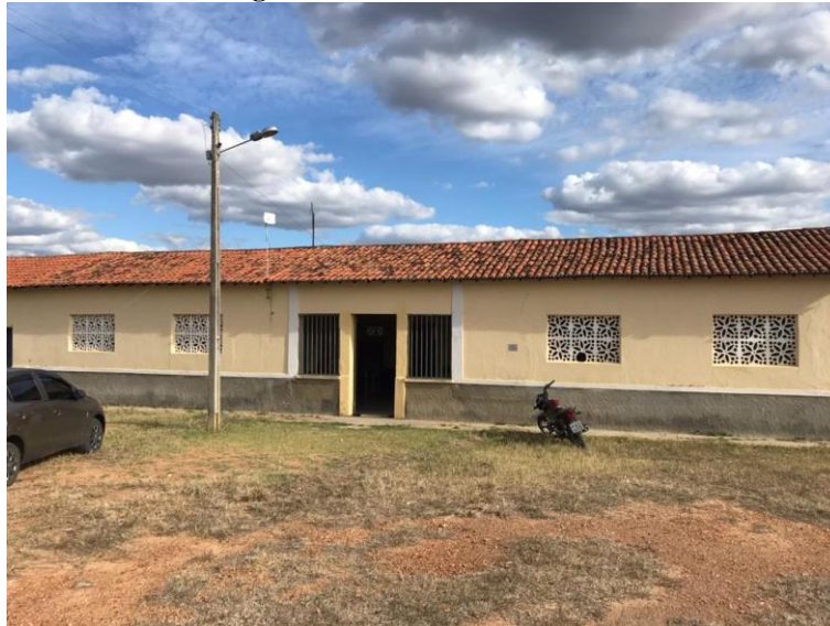
Figura 11 – Fachada da escola I5
