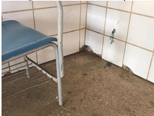
Figura 32 – Rebaixamento do contrapiso
