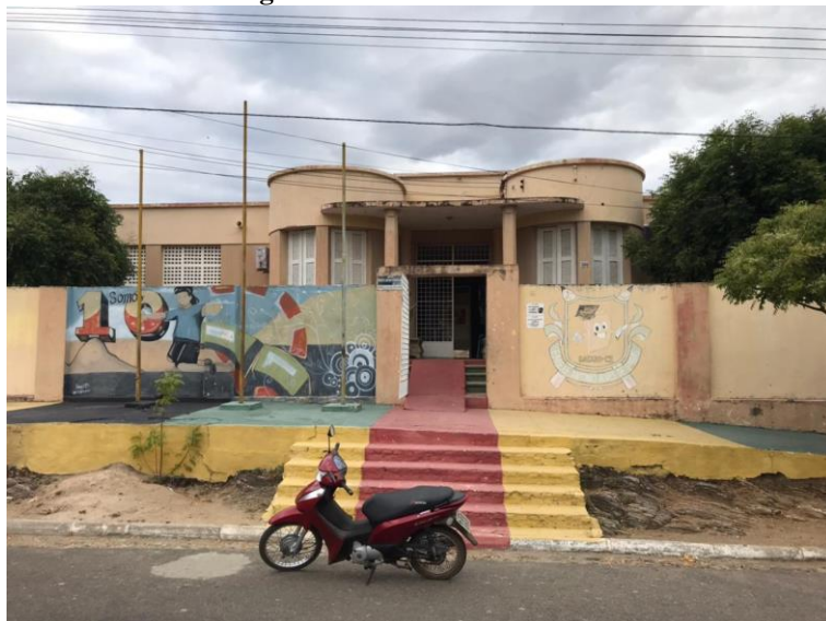
Figura 7 - Fachada da escola I2
