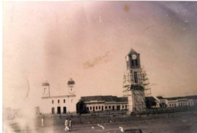
Figura 35: Coluna da hora em construção 1948
