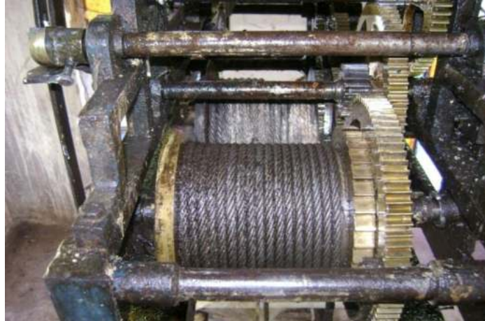
Figura 43: Vista lateral esquerda dos tambores e cabos de aço
