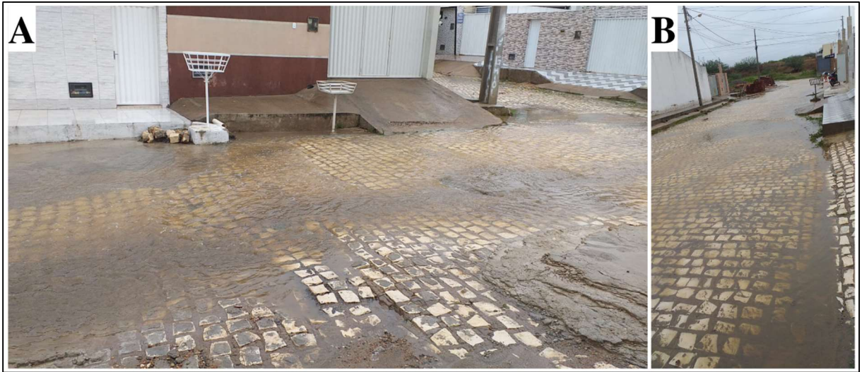
Figura 4 – Alagamentos na rua Maestro Esmerindo Cabrinha da Silva - “Rua das Águas”.
