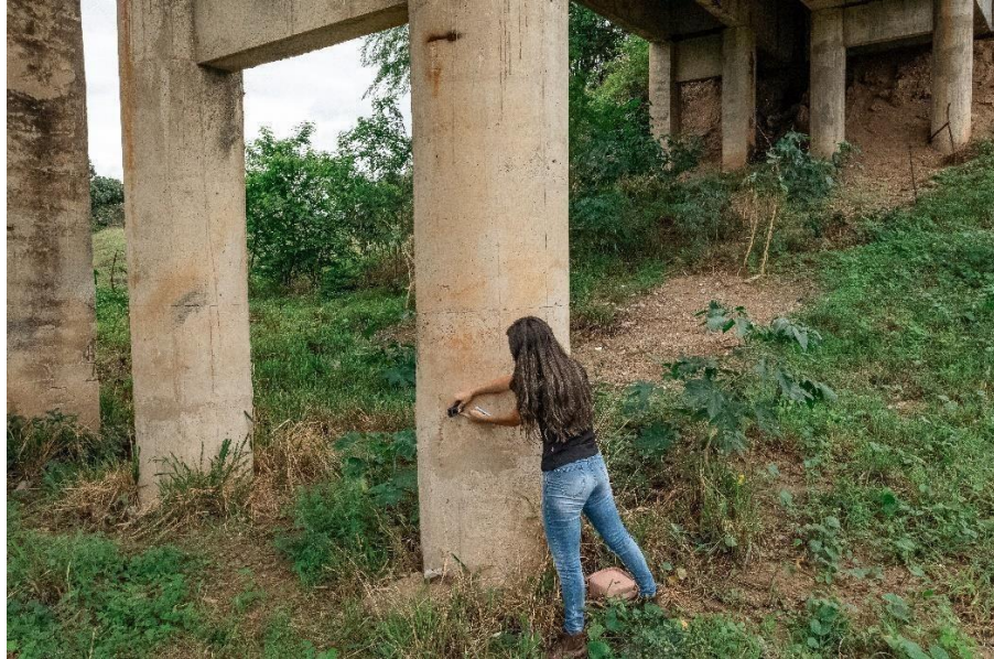
Figura 14 – Levantamento geométrico da ponte sobre o Rio Piranhas.
