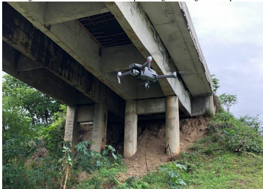
Figura 15 - Drone sendo utilizado para o registro fotográfico da ponte.
