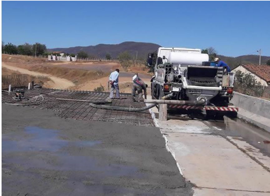
Figura 27 – Finalização da concretagem da laje da ponte sobre o Rio Piranhas
