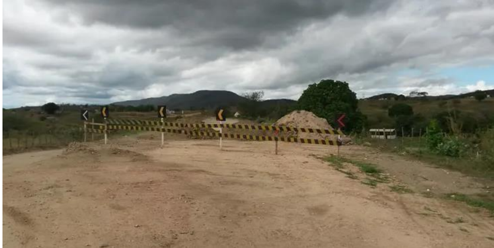
Figura 25 – Desvio da estrada da ponte sobre o Rio Piranha.
