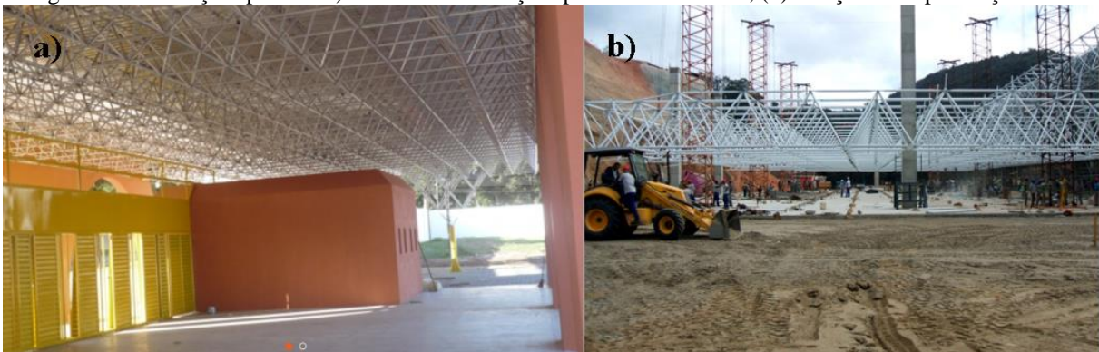
Figura 2.6 – Treliça espaciais. a) estrutura em treliça espacial de cobertura; (b) treliça em etapa de içamento.
