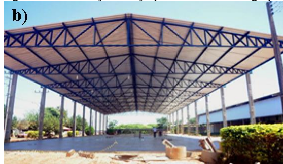
Figura 2.2 – Treliça em aço para cobertura de galpão.
