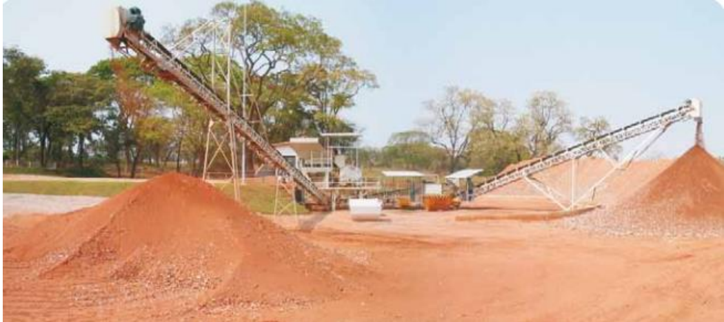
Figura 5- Usina de reciclagem de RCC.
