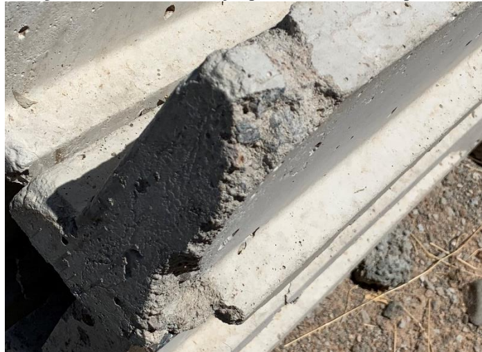
Figura 3 – Quebras em terças pré-fabricadas na empresa A.
