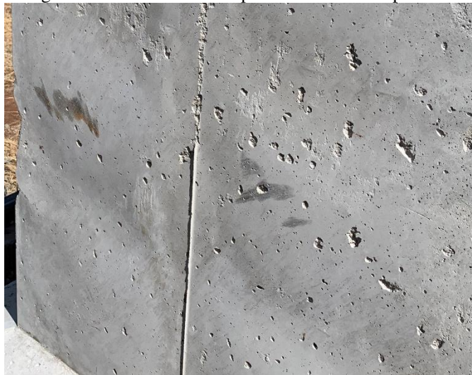
Figura 9 – Bolhas em cálice pré-fabricado na empresa A.
