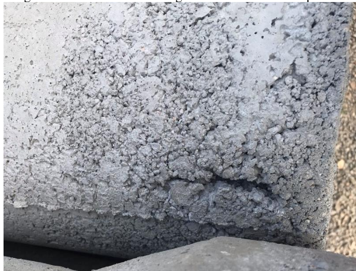
Figura 8 – Ninhos de concretagem em manilhas na empresa B.
