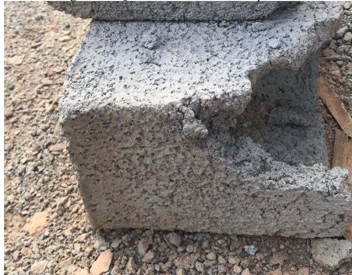
Figura 4 – Quebras em blocos na empresa B.
