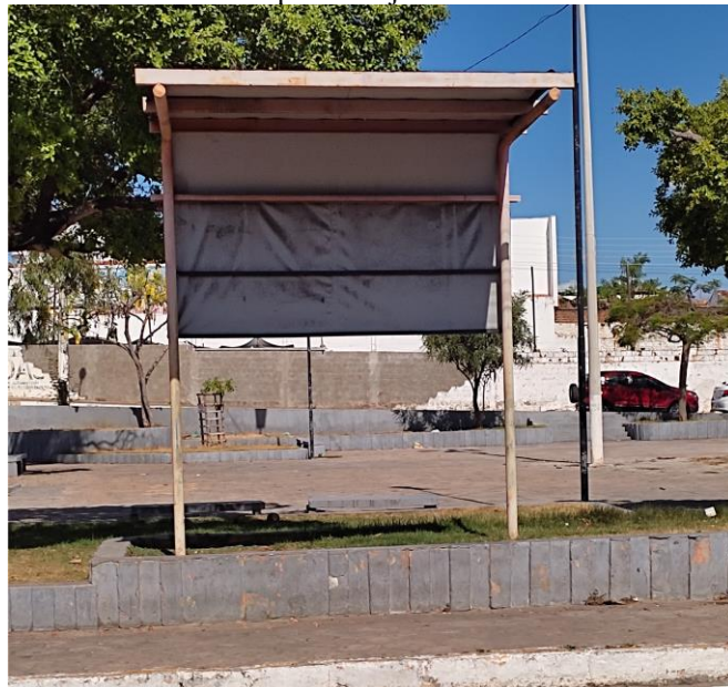
Figura 04 – Ponto de parada estruturado situado na praça da Prefeitura Municipal, no bairro Centro, no município de Cajazeiras - PB.
