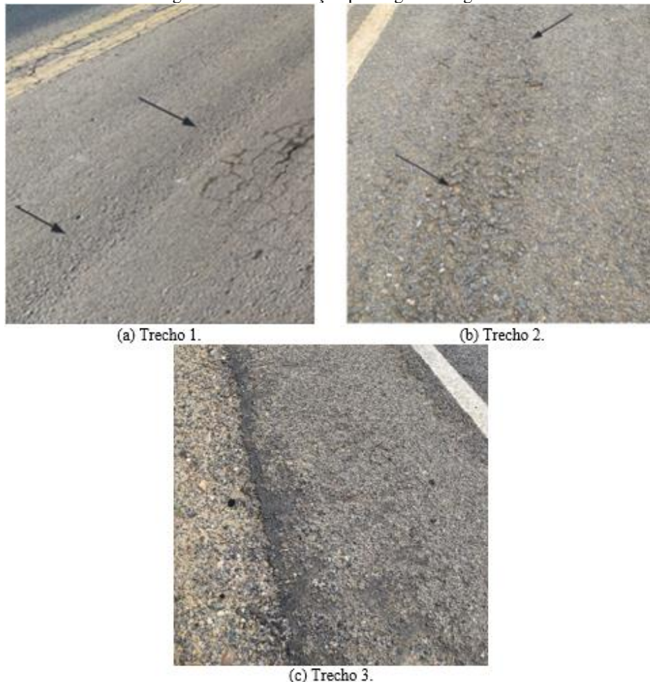
Figura 21 - Manifestação patológica: Desgaste.
