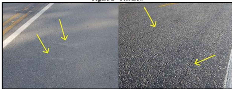
Figura 2 - Fissuras.
