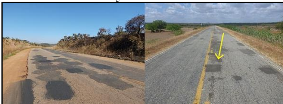
Figura 14 - Remendo.
