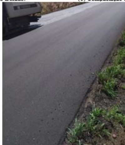
(c) Pavimento recapeado.
