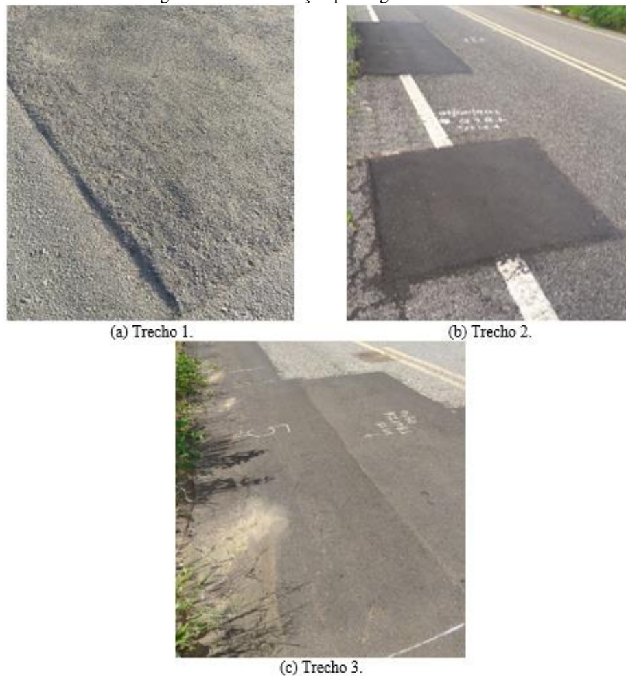
Figura 23 - Manifestação patológica: Remendo.
