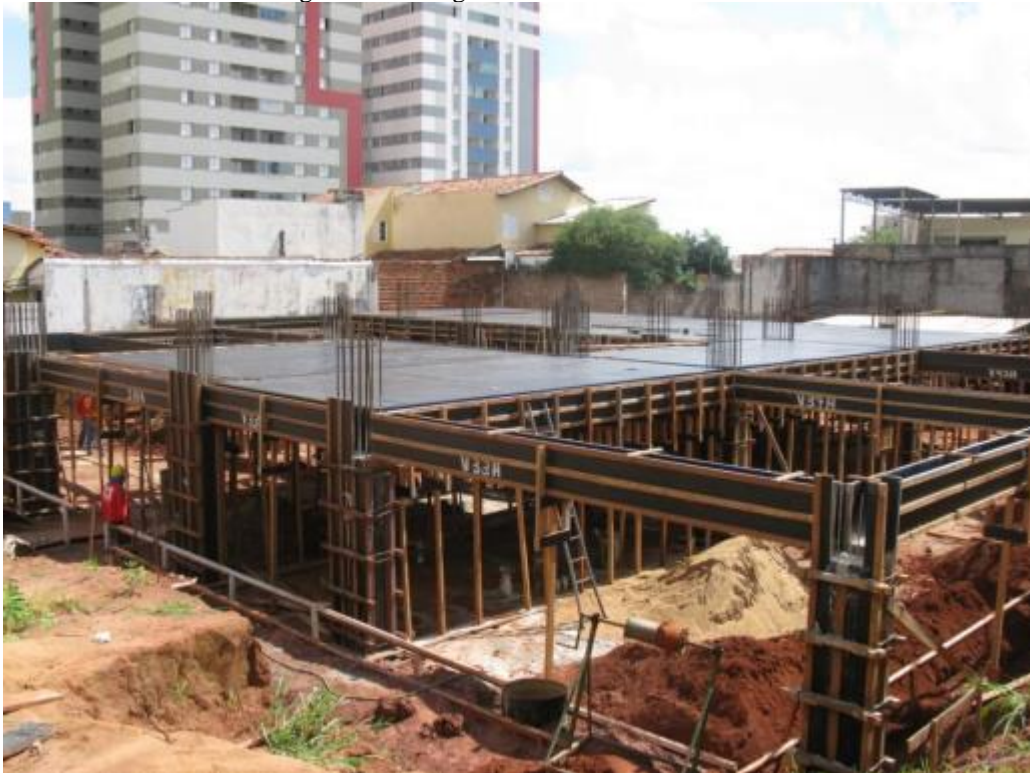
Figura 1 -Montagem dos sistemas de fôrmas.
