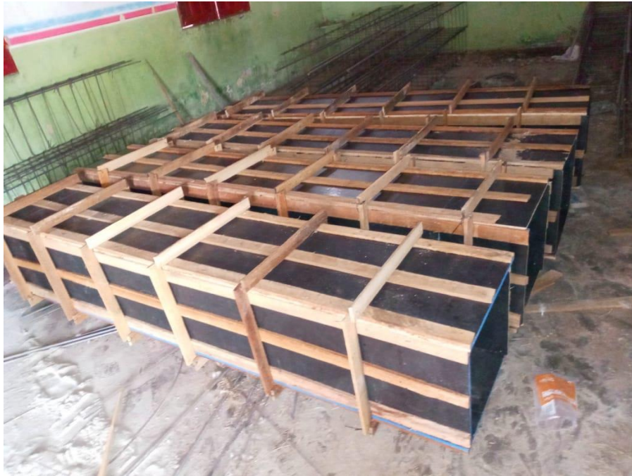
Figura 16 – Sistema de fôrma pronto da obra 2.
