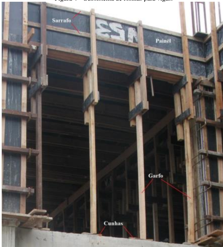
Figura 4 – Subsistema de fôrmas para vigas.
