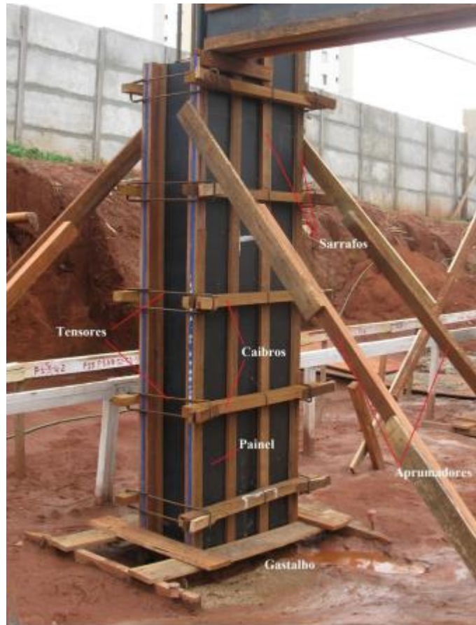
Figura 3 – Subsistema de fôrmas para pilares.
