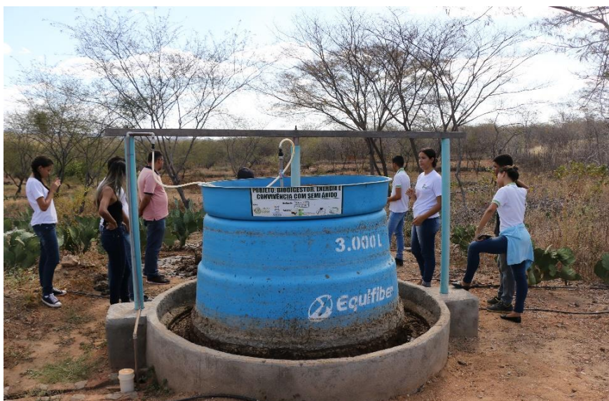
Figura 6 – Biodigestor, Assentamento Floresta, Sousa-PB
