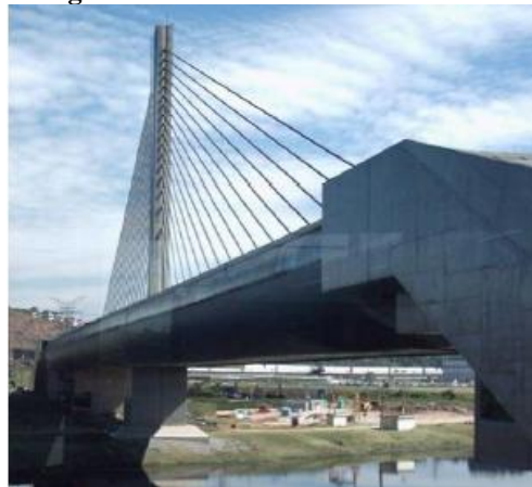
Figura 4 - Ponte estaiada em São Paulo.
